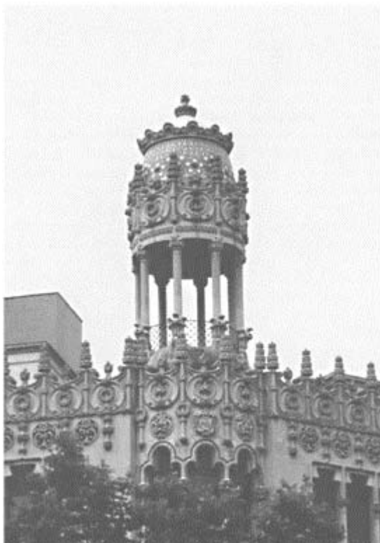
Casa Albert Lleó i Morera, Barcelona, designed by Lluís Domenèch Montaner (1905)
