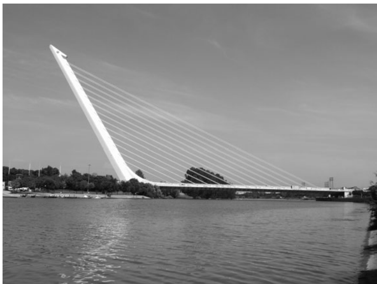
FIG 43. Puente del Alamillo, Seville, Spain
