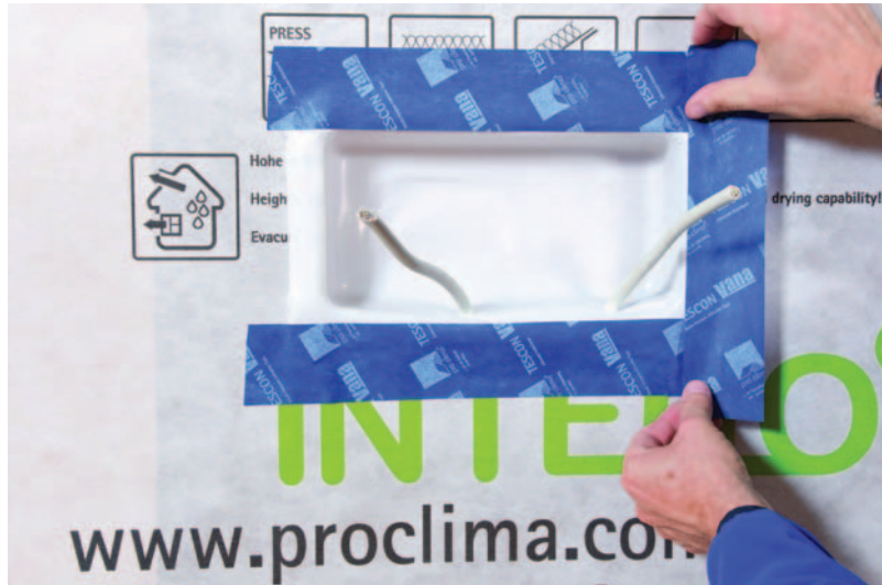
Airtight gaskets, and electrical points (Photo: pro clima Moll bauökologische Produkte GmbH).
