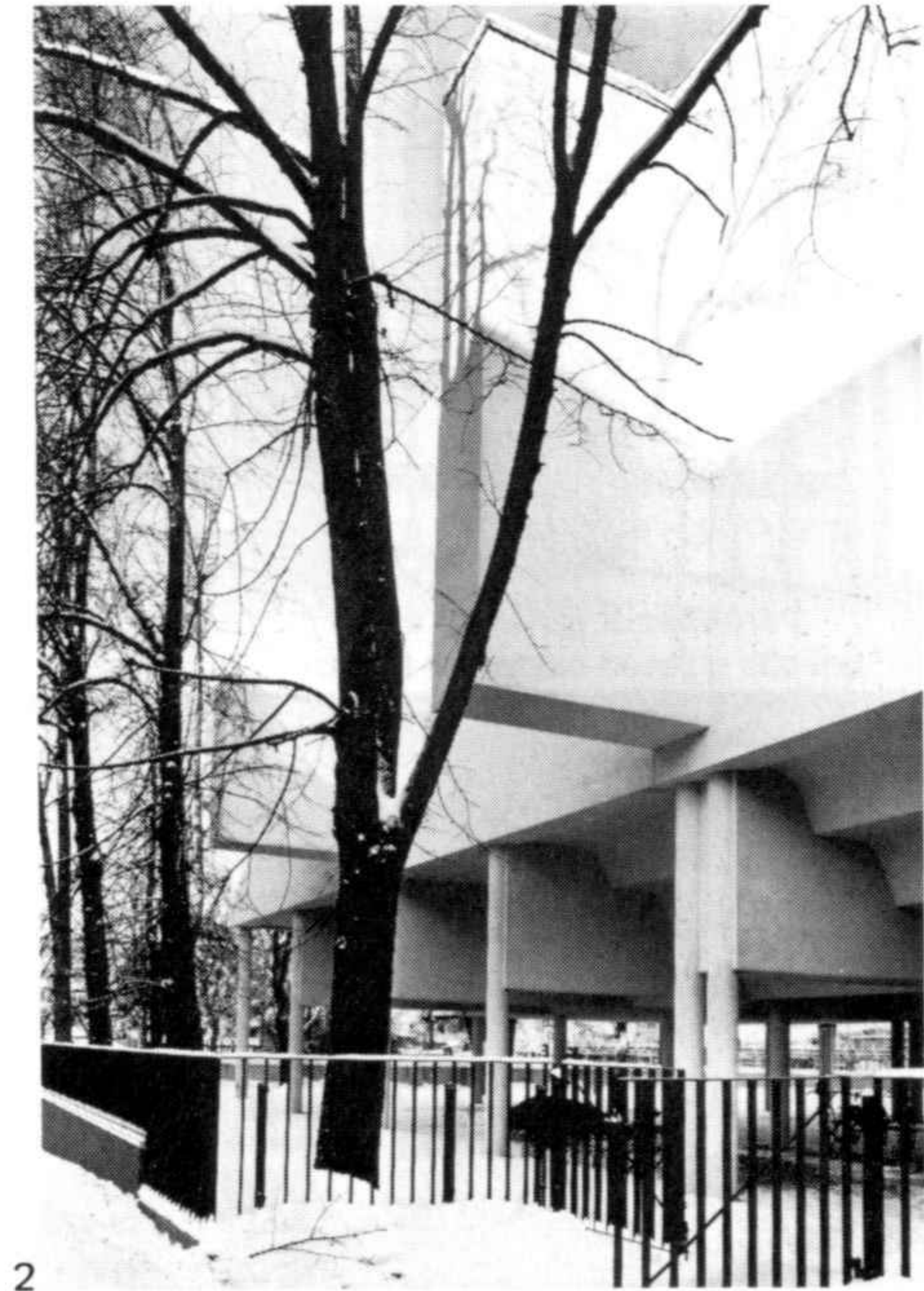
1-2 Vistas exteriores 3 Fachada desde la calle con los volúmenes salientes donde se alojan los tabiques móviles
