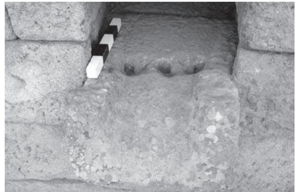
Abb. 14 Pergamon. Wasserauslass mit Einlasslöchern für Metallgitter
