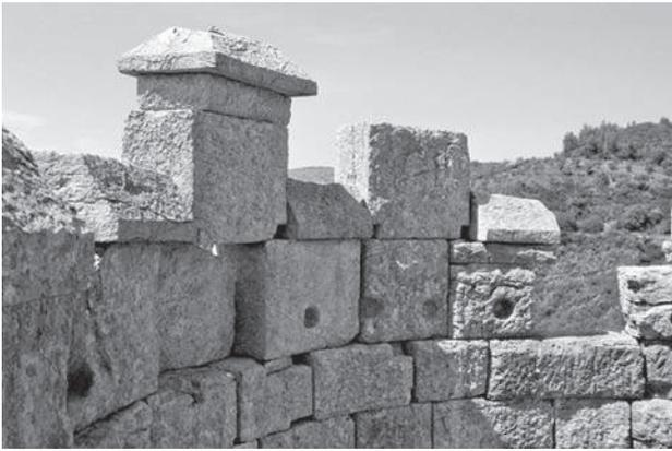
Abb. 8 Messene. Turm 10 mit Zinnen und Einarbeitungen für die Dachpfetten
