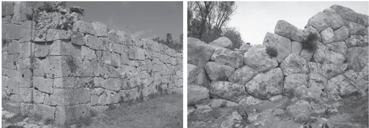
Abb. 2 Beispiele für polygonale Mauern aus dem italischen und griechischen Raum. Links: Stadtmauer von Cosa, Kurtine nordwestlich des Nordosttores. – Rechts: Stadtmauer von Eretria, Kurtine südlich der Akropolis
