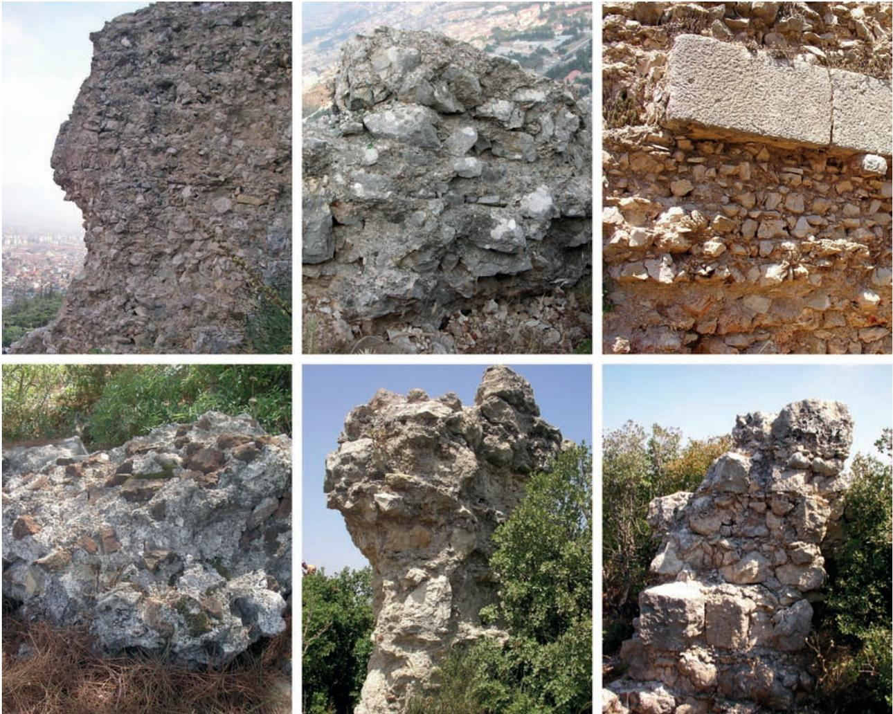
**Abb. 4** Die unterschiedlichen Mörtelkerne der spätantiken Stadtmauer von Antiochia am Orontes. Oben links und Mitte: Kurtinen im südlichen Bereich des Silpiosberges. – Oben rechts und unten links: Kurtinen im östlichen Bereich des Silpiosberges. – Unten Mitte und rechts: Kurtinen im südöstlichen Bereich des Staurinberges
