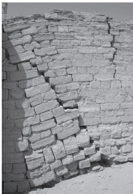
Abb. 4 Europos-Dura. Kurtine zwischen Turm 14 und 15, in Folge von Unterminierung abgesackt
