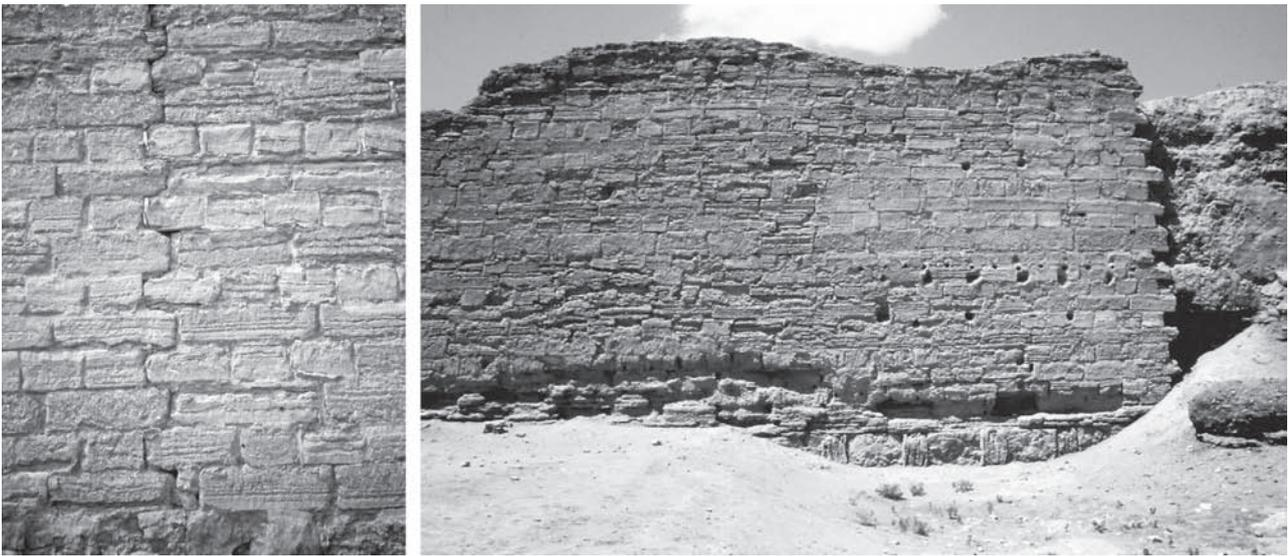
**Abb. 9** Die verschiedenen Mauerwerkstechniken der Stadtmauer von Europos-Dura. Links: Kurtine 14–15, in ruhiger Periode mit Blöcken guter Qualität und sorgfältiger Fugung errichtet. – Rechts: Kurtine 22–23, eine der zuletzt errichteten Steinkurtinen mit Blöcken schlechter Qualität, gegen die Schichtung versetzten Blöcken und nachlässiger Fugung; rechts im Anschluss daran in direkter Folge errichtete Lehmziegelkurtine
