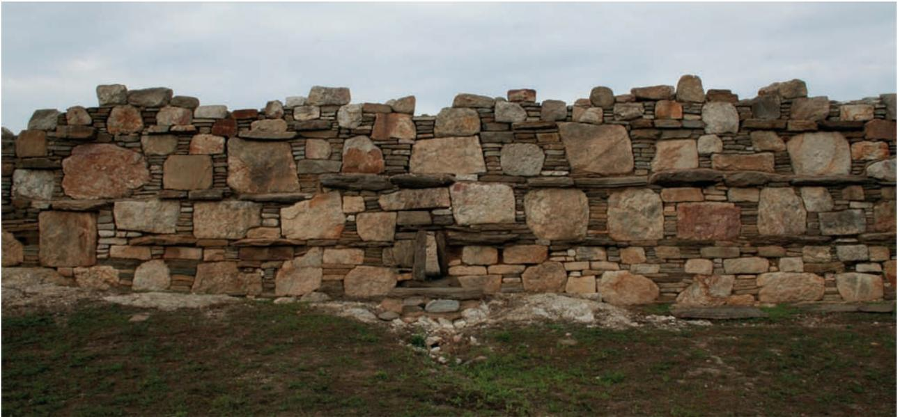
**Abb. 10** Stageira (Chalkidiki). Leitermauerwerk an der Kurtinenaußenseite der Stadtmauer auf dem Gipfel des Südhügels
