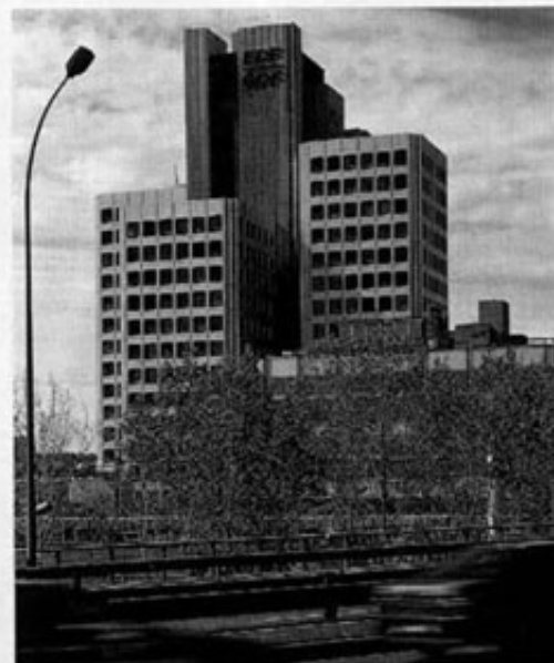
Atelier de Montrouge, offices of Électricité de France , Porte de Sèvres, Paris (1970)
