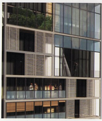
Personalización de la fachada Individual customization of the facade Segunda piel mostrando la personalización de la fachada Second skin showing customization of the facade
