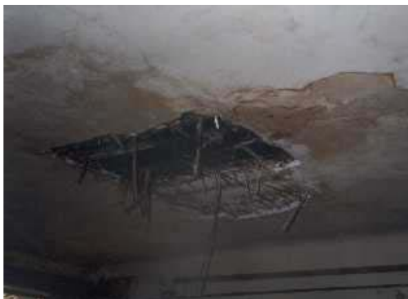
Fig.1.3.1.3-11 Efectul tiglelor sparte sau deplasate, neinlocuite sau reparate
