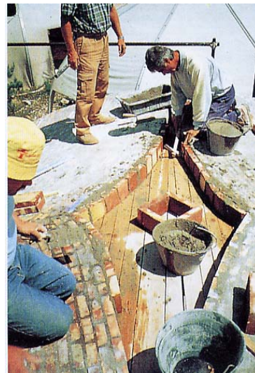
Fig.1.3.2.3-3 Bolta cilindrica in 'coada de randunica'
