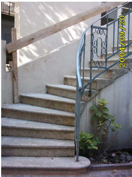
Fig.1.3.4.4-1 Solutii constructive pentru scari cu trepte din piatra naturala
