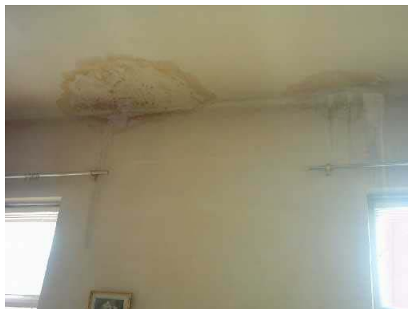
Fig.1.3.1.3-12 Efectul jgheabului infundat I (interior: sub planseul de pod)
