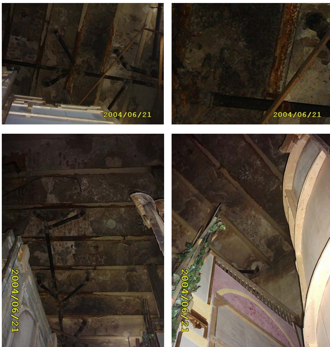
Fig.1.3.2.4-1 Grinzi metalice puternic atacate de rugina
