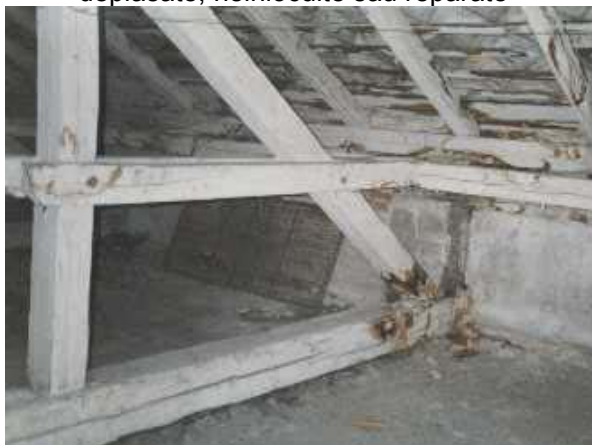
Fig.1.3.1.3-11 Efectul tiglelor sparte sau deplasate, neinlocuite sau reparate
