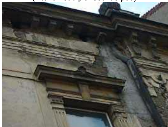
Fig.1.3.1.3-12 Efectul jgheabului infundat I (interior: sub planseul de pod)
