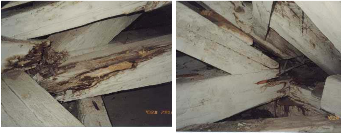
Fig.1.4.3-1 Nod de reazem distrus prin putrezire
