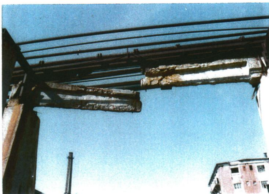
Foto II.48. Element prabușit din greutate proprie datorită coroziunii totale a armăturii
