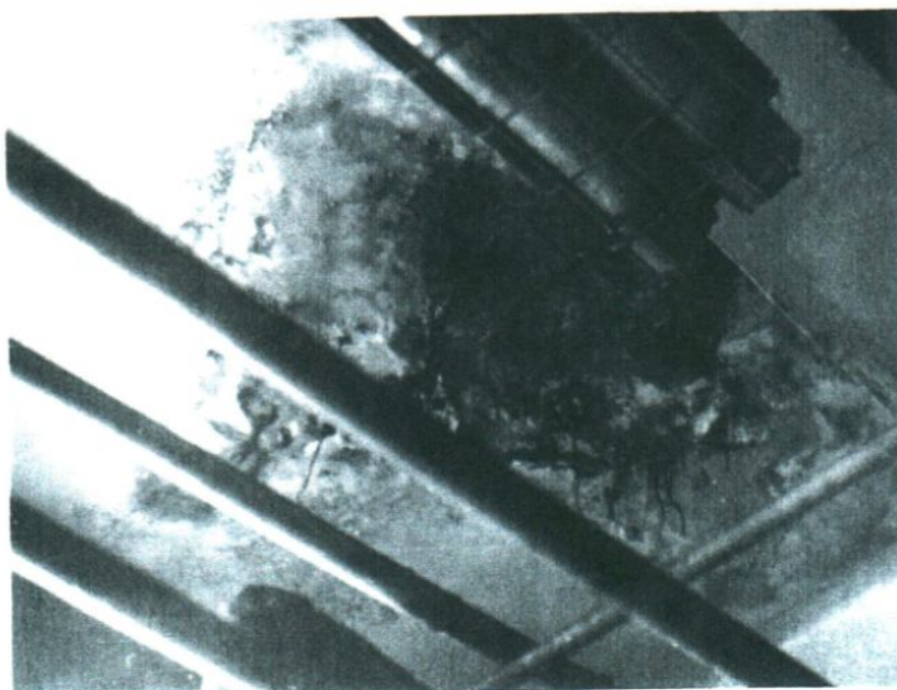
Foto II.33. Degradări datorate acetatului de butil
