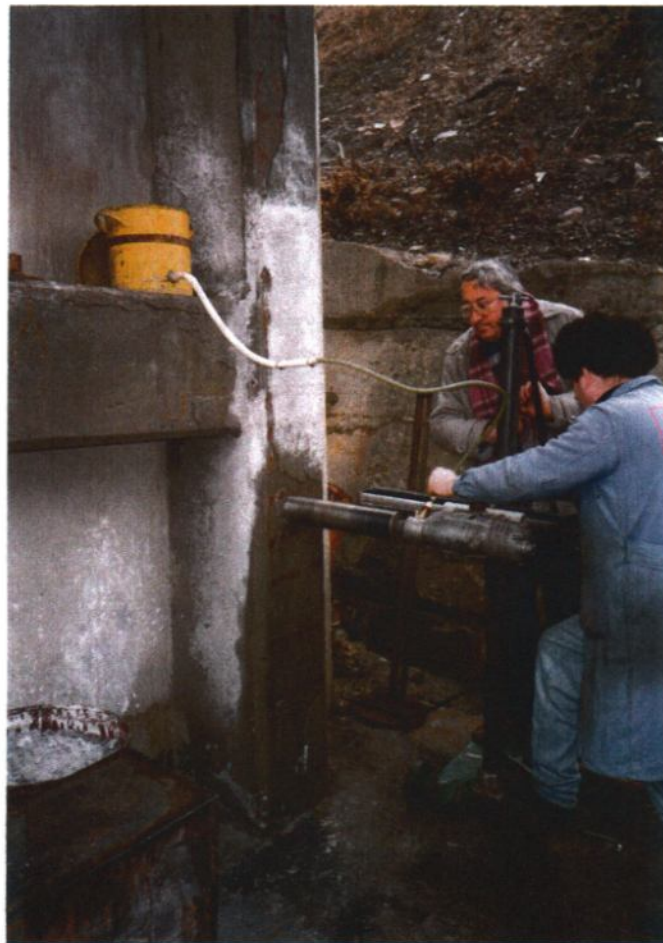
Foto. V.10. Forarea unei carote într-un stâlp din beton armat
