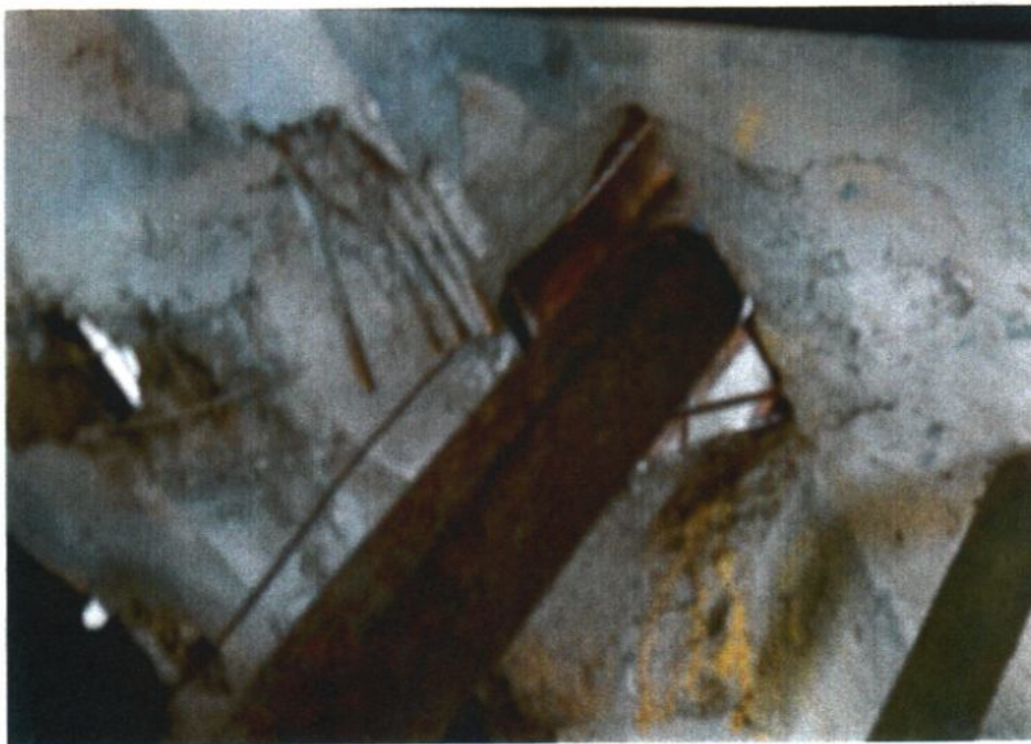
Foto III.13. Grindă tăiată pentru trecerea unei conducte
