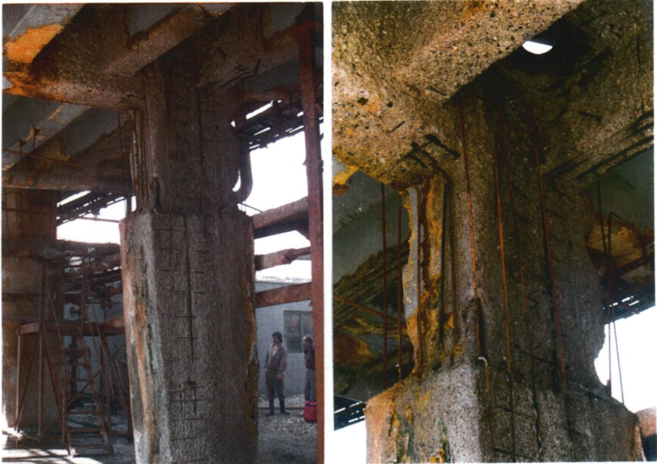
Foto III.11. Consolidări întrerupte, puternic degradate (ansamblu și detaliu)
