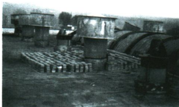
Foto. VI.1. Încărcarea cu cărămizi a acoperișului
