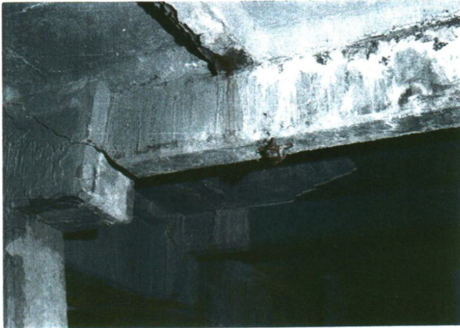
Foto II.39. Nod rigid de cadru crăpat datorită tasării terenului
