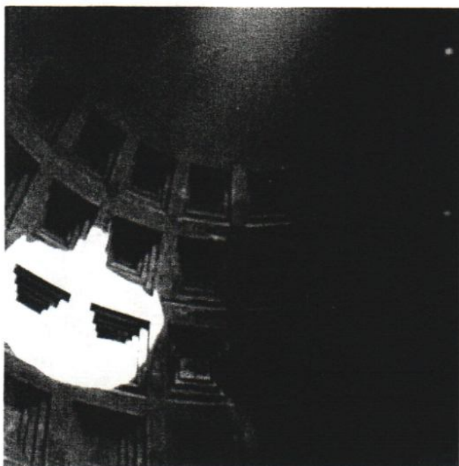
Foto I.5. Panteonul (119 e.n.), acoperit cu o calotă de 45 m diametru, din piatră brută înecată în mortar hidraulic și armată cu arce din cărămidă, așezată pe ziduri de 5 m grosime
