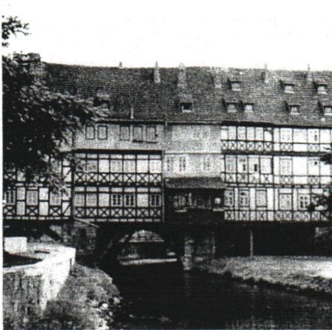
Foto I.4. Kramerbrücke (podul negustorilor) din Erfurt, peste râul Gera, cu case din paiantă datând din anul 1325
