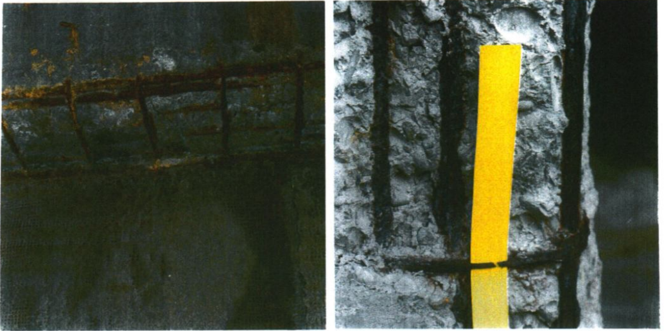
Foto II.27. Degradari datorate acidului carbonic
