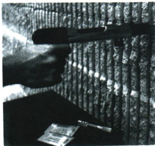
Foto V.6. Aparatul pentru împușcat bolțuri în beton (firma JAMES INSTRUMENTS)
