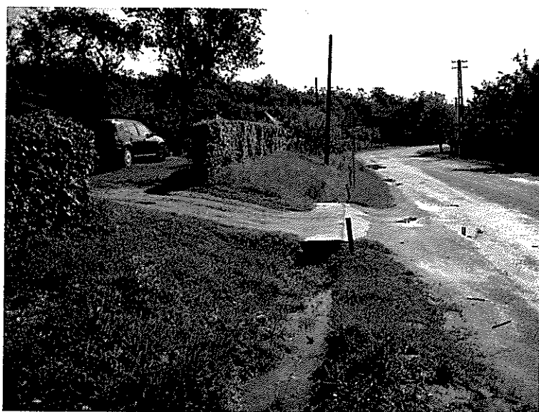
Foto 4. Evacuare necorespunzătoare a apelor de suprafață
