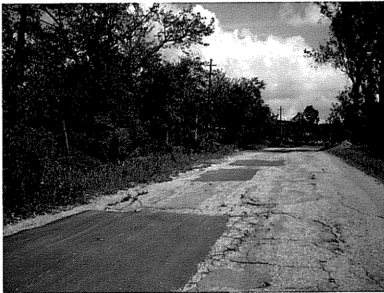
Foto 15. Suprafață de rulare faianțată
