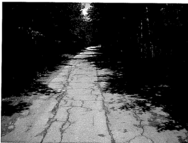
Foto 5. Crăpături multiple; predomină crăpăturile longitudinale pe urma roților
