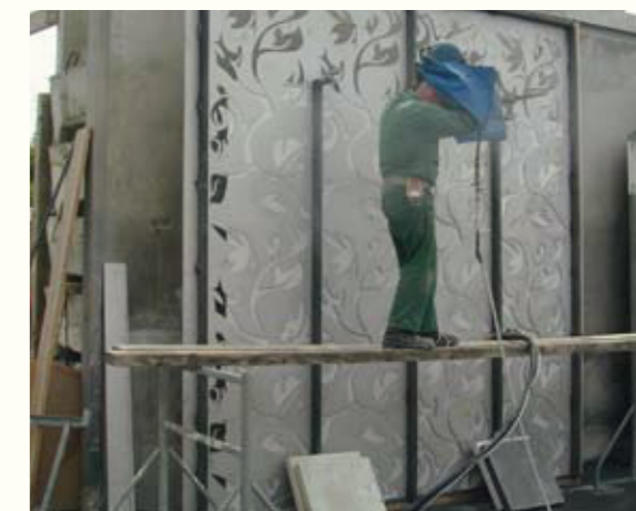
haut : médiathèque Saint-Julien-de-Concelles, avril 2008 bas : pochoir à béton, logements La Solvardière, Saint-Herblain, 2004
