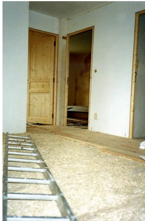
de chanvre et revêtues de plaques de plâtre, et pose l'isolation en chanvre et le lambris sous les combles dans la mezzanine de la chambre des parents.
