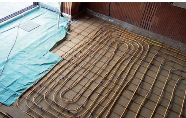
**briques alvéolaires apportent une bonne inertie thermique dans des pièces de vie, dispositif complété par un chauffage par le sol à eau chaude basse température posé sur des plaques d'isolant en laine de bois.** Cette combinaison produit une chaleur homogène très agréable. Les murs à ossa-
