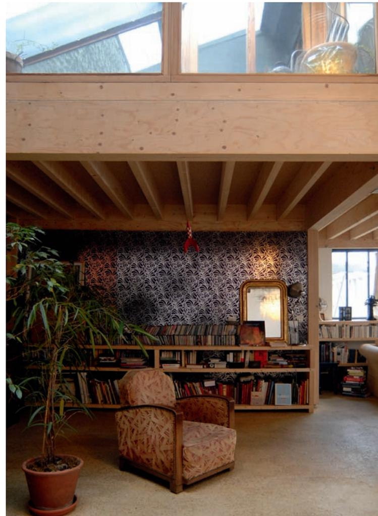
davantage de lumière et permettre au regard de s'échapper à l'extérieur sans être vu. Il a fallu également rattraper une différence de niveau par une dalle en béton. Enfin le mur du fond, mitoyen avec un immeuble, était en mauvais état et humide; il a été doublé par un nouveau mur en ossature bois séparé du mur existant par un vide de 15 cm. Cet espace, qui permet à l'humidité du mur de s'évacuer, est également mis à profit pour faire passer les deux descentes d'eaux pluviales du patio.
