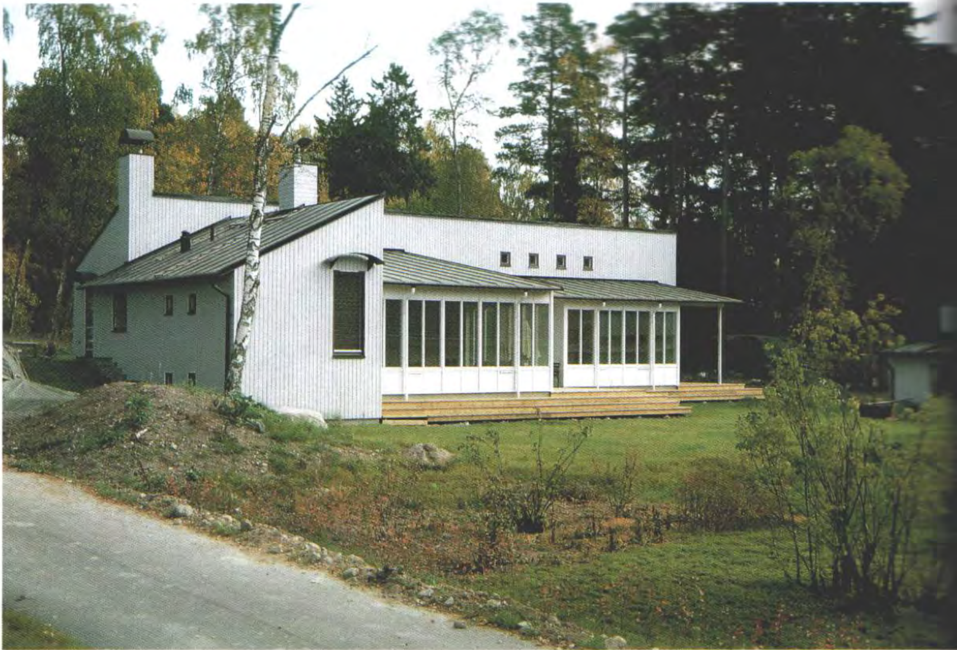
Above: the southwest exposure shows large glazed doors opening onto the wooden terraces and the garden. Arriba: la exposición sudoeste permite grandes puertas acristaladas abiertas hacia las terrazas de madera y el jardín.
