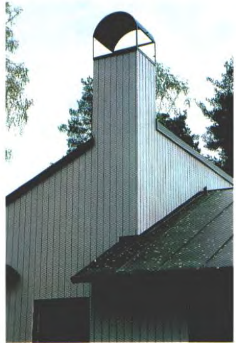
Detalle de una salida de chimenea y de la cubierta de chapa.
