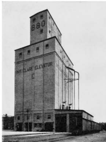
BALTIMORE UND OHIO EISENBAHN GES. KOHLENSILO
