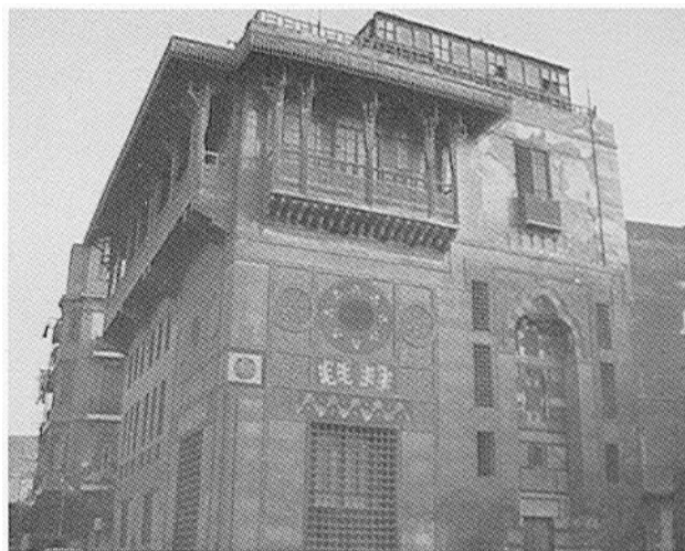
Pl. 105. The sabīl-kuttāb of Sultan Qāyṭbāy at Ṣalība.
