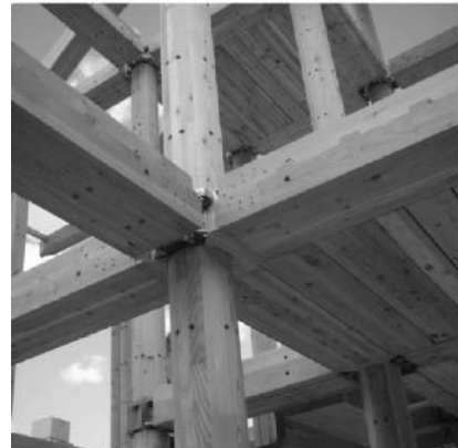
(d) Beam and post construction
