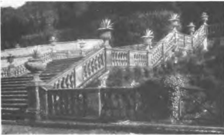
Fig. 18.—Frascati. Villa Torlonia. Garden stairway.
