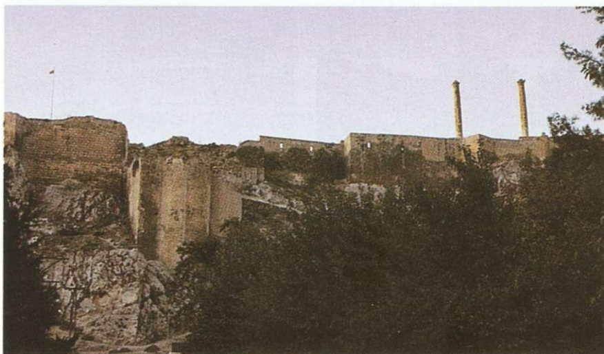
Slika 29. Zidine Edese sa stupovima, pogled odozdo
