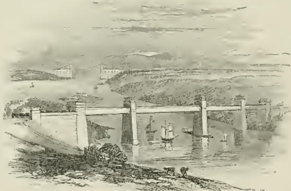
Britannia Tubular Bridge.
