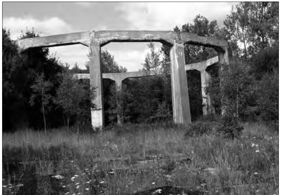
Seitenansicht der rätselhaften Betonkonstruktion
