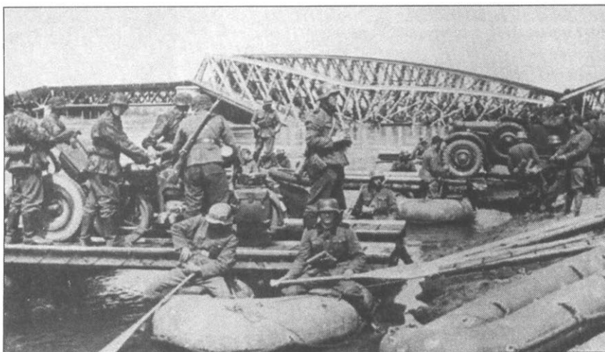
Форсирование реки с помощью понтонов. Два понтона соединялись мостовым пролетом. В движение импровизированный плот приводили с помощью весел. На переднем понтоне через реку переправили 37-мм пушку и мотоцикл с коляской. На заднем плане виден переправленный автомобиль. Подразделения дивизии «Das Reich» захватили плацдармы на восточном берегу Днепра 4 июля 1941 года.
