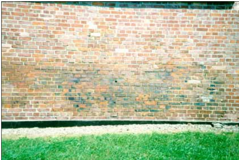
Foto 17: Entlausungskammer in Stutthof, Ostseite. Blaue Flecken an der Wand belegen den Einsatz von Zyklon-B. © Carlo Mattogno
