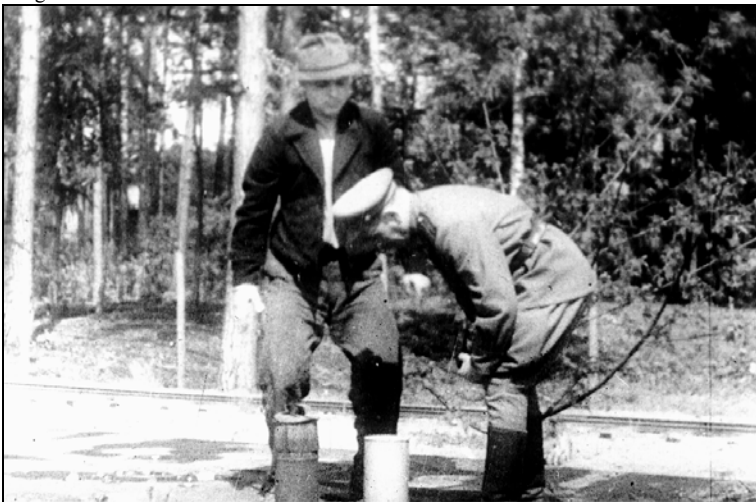
Foto 11: Entlausungskammer in Stutthof, Dach. Metallenes Rohr mit Deckel, das in die Einwurfluke führt. Sowjetische Aufnahme von 1945. Neben dem Rohr sieht man eine Zyklon-B-Dose. AMS, Signatur 6816.
