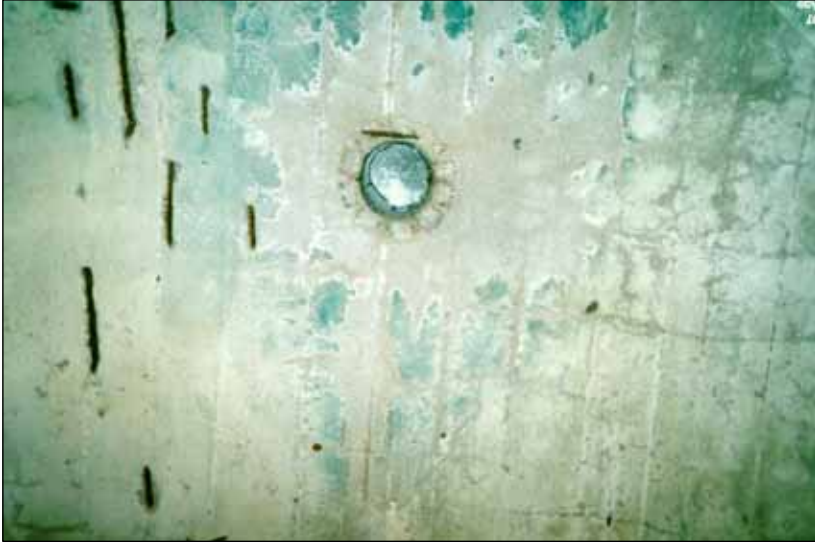
Foto 10: Entlausungskammer in Stutthof, Inneres. Runde Öffnung in der Mitte der Eisenbetondecke; man beachte die typische Blaufärbung der Eisenzyanide. Die Öffnung diente zur Einführung von Zyklon-B in die Gaskammer.
