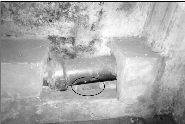
Foto 8: Entlausungskammer in Stutthof, Inneres, Westwand; gußeisernes Verbindungsrohr zum außerhalb der Gaskammer angebrachten Ofen, der zum Erhitzen der Luft dient. Ursprünglich war das Rohr von einem Mauerwerk umgeben, das dem auf dem Foto erkennbaren entspricht, jedoch aus durchlöchernten Ziegeln bestand. Einer dieser Ziegel ist noch heute unten hinter dem Rohr sichtbar (Kreis). © Carlo Mattogno
