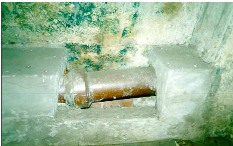
Foto 8: Entlausungskammer in Stutthof, Inneres, Westwand; Gußeisernes Verbindungsrohr zum außerhalb der Gaskammer angebrachten Ofen, der zum Erhitzen der Luft dient. Ursprünglich war das Rohr von einem Mauerwerk umgeben, das dem auf der Foto erkennbaren entspricht, jedoch aus durchlöchernten Ziegeln bestand. Einer dieser Ziegel ist noch heute unten hinter dem Rohr sichtbar (Kreis). © Carlo Mattogno
