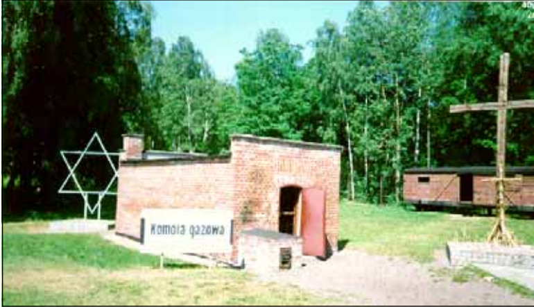
Foto 1: Entlausungskammer in Stutthof, heutiger Zustand (1997), südwestlicher Rand. Rechts sieht man einen der beiden auf der Schmalspur stehenden WaggonS. © Carlo Mattogno.
