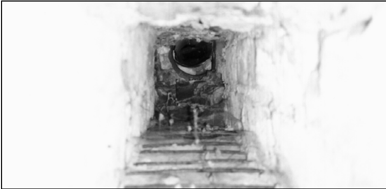
Foto 7: Entlausungskammer in Stutthof, Südseite. Ofen zum Erhitzen der Luft in der Gaskammer. Inneres der Brennkammer. Unten sieht man den Planrost, oben die runde Öffnung der Verbindung mit dem in der Entlausungskammer angebrachten gußeisernen Rohr. © Carlo Mattogno
