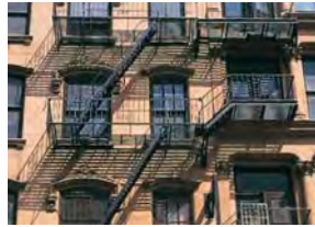
مهرب حريق mahrab Hareeq fire escape
