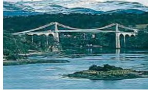
جسر jjssr bridge
