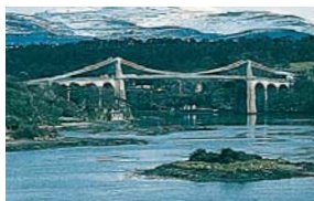
die Brücke bridge
