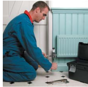
der Klempner plumber
