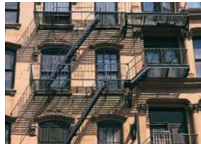
die Feuertreppe fire escape
