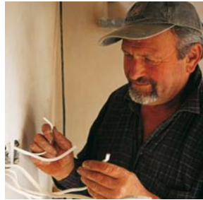
der Elektriker electrician
