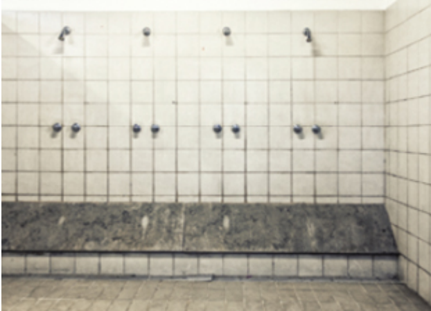
showers der Duschaum
