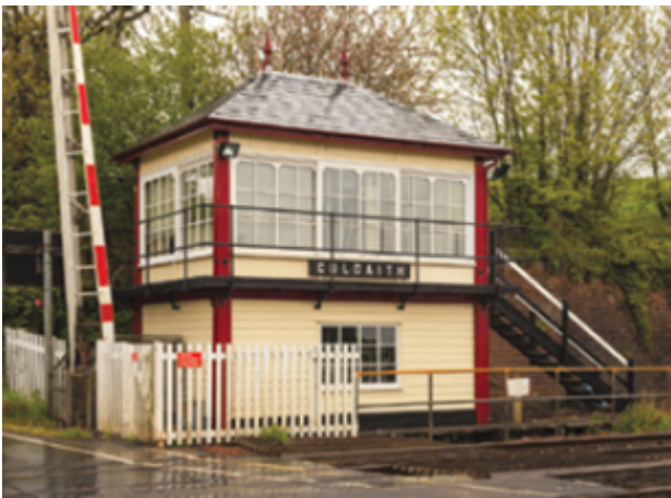
signal box das Stellwerk
