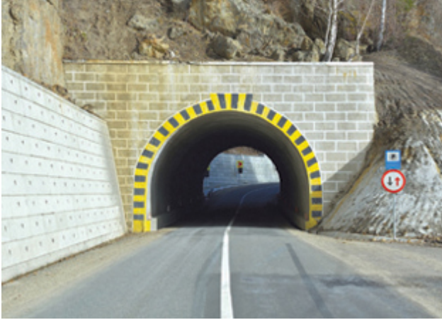
tunnel der Tunnel
