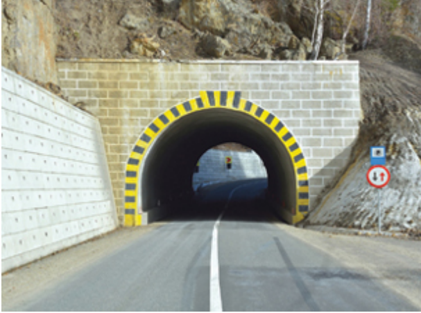
tunnel el túnel
