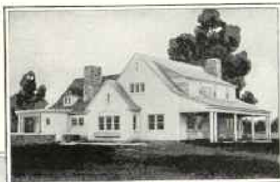
TWO OF THE TENANT HOMES
