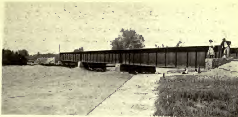
PUENTE DE CHILLÓN (ANCON-LIMA RAILWAY).
