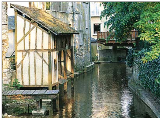
The Lavoir des Cordeliers in Vendôme's Parc Ronsard
