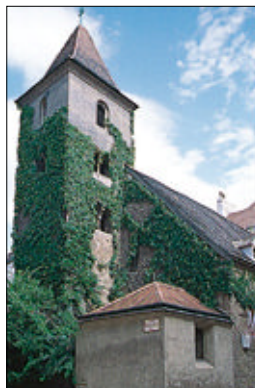
Ivy-clad façade of Ruprechtskirche
