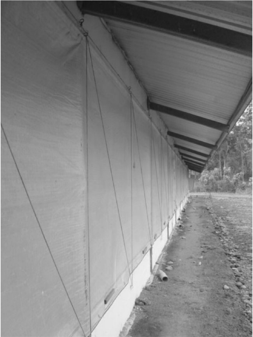
Fig. 5.8. 1.2-m roof overhang.
