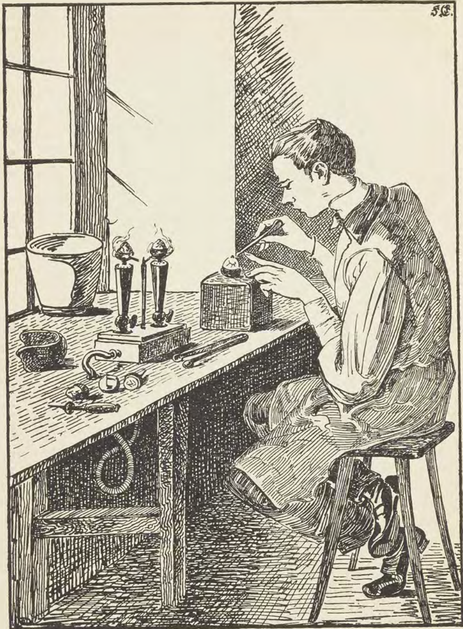
Abb. 28 Das Einfitten der Diamanten in die Doppen.
