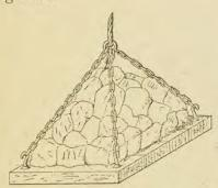
TRANSPORT DU SEL GEMME A LA SURFACE. — Le transport du sel gemme se fait au moyen de châssis (wagonets) circulant sur des rails en acier espacés de 0,60 à 0<sup>m</sup>,70. Le poids du rail est de 6 <sup>1</sup>/<sub>2</sub> kilog. par mètre courant.
