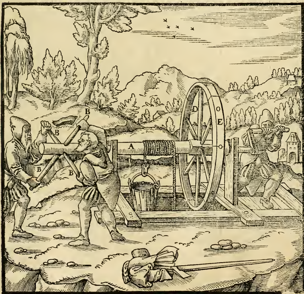
Sucula A. Vectes recti B. Vectis usitatus C. Rotæ radij D. Eiusdem curuaturæ E.
