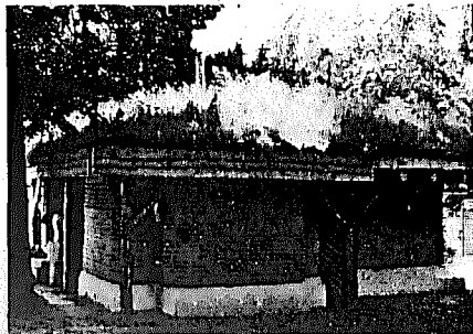
5 Versuchsbau der Gesamthochschule Kassel (der vordere Teil wurde mit der Lehmstrang- -präBtechnik errichtet).
