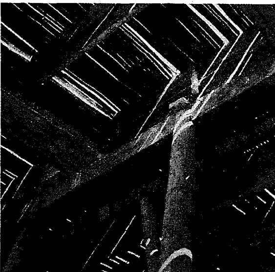
Una vez listos los casetones, se colocan entre el refuerzo de las vigas y viguetas de la losa, en la forma como se muestra en la fotografía superior.
