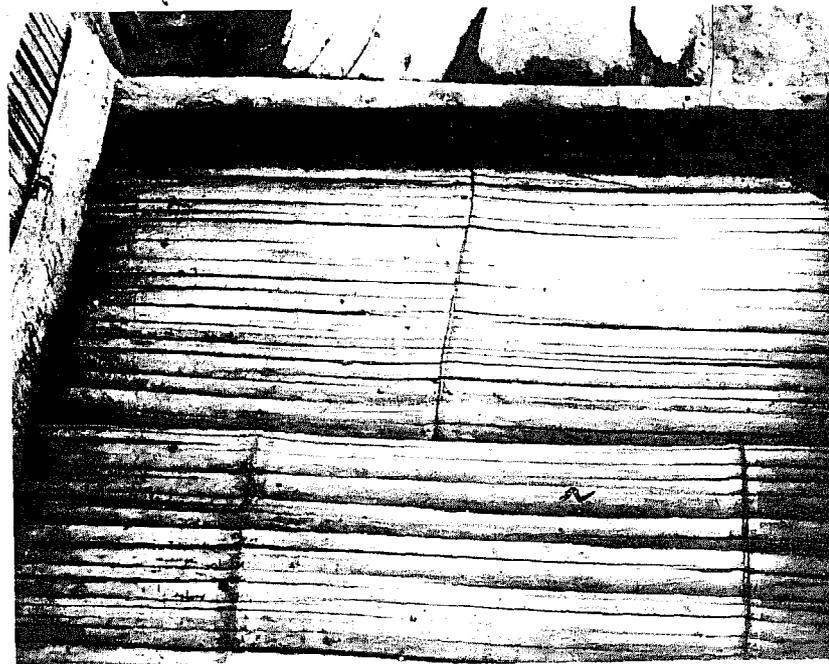
esterilla se coloca sobre entresuelos de bambú con una separación máxima entre centros de 30 cms., y se asegura a ellos por medio de puntillas o amarrándola con alambre galvanizado, que debe ser lo suficientemente apretado para que no sirva de tropiezo sobre el piso.
