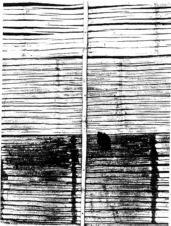
Por lo general en los muros de bahareque la esterilla se fija a los parales ya sea por medio de cintas delgadas de latas de bambú, como se indica en la fotografía superior, o por medio de alambre galvanizado que se asegura a las cabezas de las puntillas como se observa en la fotografía inferior
