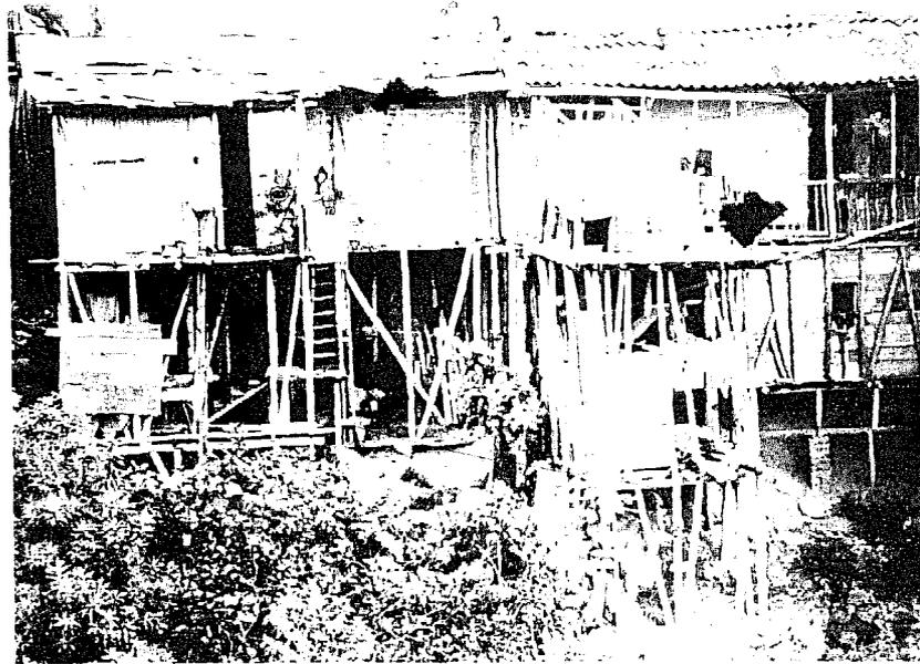
Las fotografías muestran diversos aspectos de la forma antitécnica, desordenada y rústica, como se colocan y apoyan los puntales de bambú que sostienen la parte posterior de la vivienda, dando un aspecto muy desagradable y deprimente, lo que ha contribuido a crear la "fobia" que existe por las construcciones de bambú.
