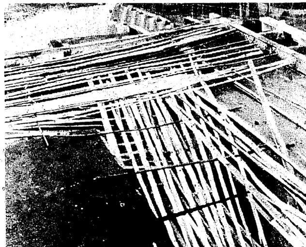
Las vigas  $B_1$  y  $B_2$  eran continuas a lo largo de la parte frontal de la estructura y estaban soportadas en sus extremos por vigas en cantilever. Las vigas interiores  $B_2$  con una luz de 22', eran continuas sobre ambos soportes. La luz de las vigas  $B_1$  era de 17' y continuas sobre soportes interiores y parcialmente continuas sobre los soportes en cantilever exteriores.
