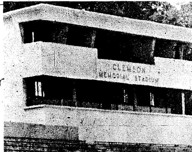
2. El concreto en las losas del segundo y tercer piso han desarrollado fisuras en dirección paralela al refuerzo principal de bambú en un punto localizado en el centro de los 60 pies de la losa. El concreto de la cubierta muestra iguales fisuras en el cantilever que ha progresado hasta la viga B<sub>4</sub>. Todas estas fisuras son paralelas a la dirección del refuerzo principal y por esta razón no afecta la seguridad de la estructura.
