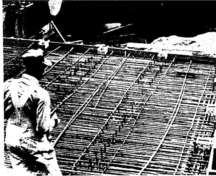
La fotografía muestra la colocación del refuerzo de bambú en la losa S, y de las vigas y viguetas correspondientes al edificio destinado al Taller de Carpintería. El refuerzo negativo falta aún por colocar en la losa, en la zona de los soportes.
