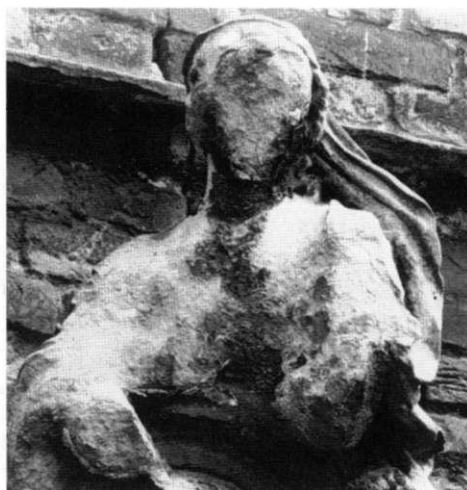
Figure 23.18 A monument before and after deterioration caused by acid rain. [Westfälisches Amt für Denkmalpflege.]
