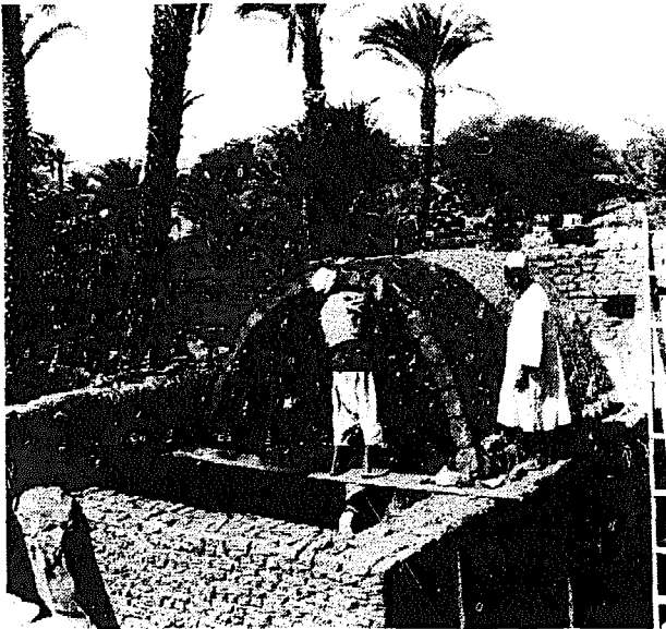
FIGURE 310 : LE MAÇON NUBIEN S'APPRETE A « COLLER » LA BRIQUE SUR LA COUCHE DE MORTIER. ON DISTINGUE SUR UNE FACE DE LA BRIQUE LES SILLONS, CREUSES AU MOULAGE, ET QUI AMELIORE- RONT L'ADHERENCE DE LA BRIQUE AU MORTIER
