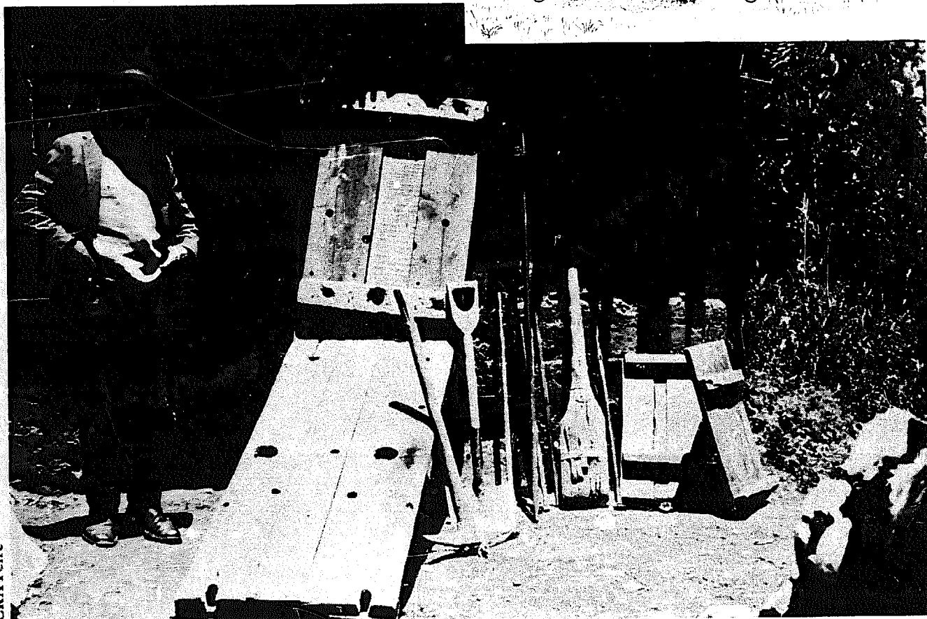
FIGURE 59 : LES OUTILS DU PISÉUR PÉRUVIEN (HUANCATELICA)
