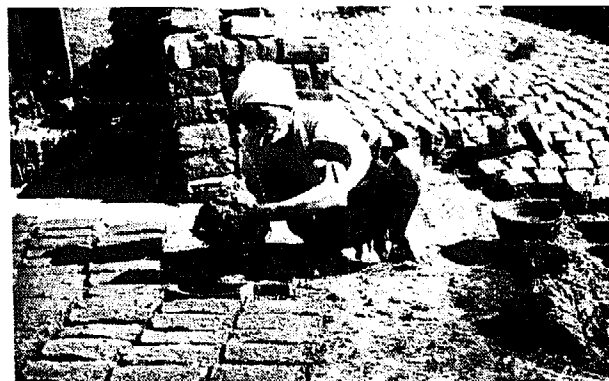
FIGURE 156 : LA BOULE EST MOUILLEE AVANT D'ETRE JETEE DANS LE MOULE
