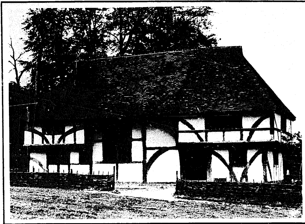
FIGURE 291 : CONSTRUCTION EN PAN-DE-BOIS : « BAYLEAF FARMHOUSE », XVI e SIECLE (MUSEE EN PLEIN AIR DE SINGLETON, ANGLETERRE)
