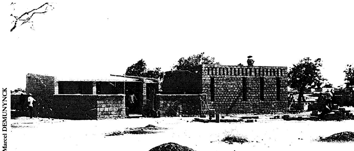
FIGURE 224 : REALISATION EN BRIQUES DE TERRE COMPRESSEES A CISSIN, OUAGADOUGOU (HAUTE-VOLTA)
