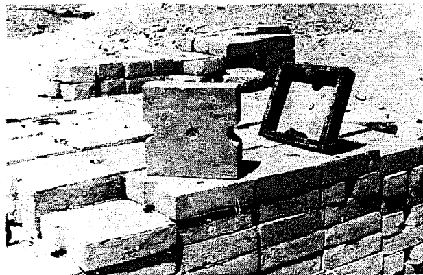
FIGURE 211 : MOULE ET BRIQUE (MAISON EXPERIMENTALE DE LIMA)
