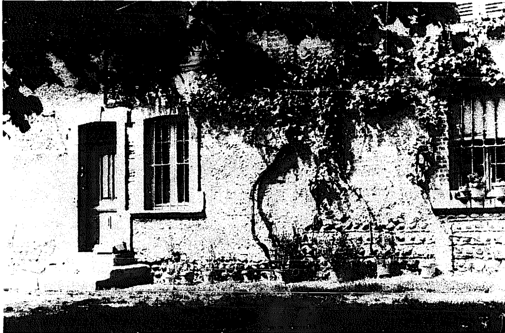
FIGURE 47 : FAÇADE DE LA PARTIE HABITATION
