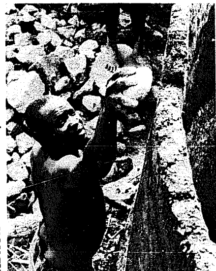
FIGURE 133 : LES FACES DU MUR SONT LISSEES AVEC UNE PIERRE
