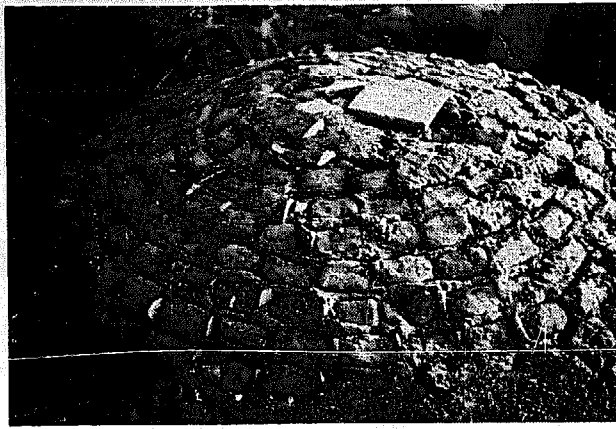
FIGURE 321 : COUPOLE CONSTRUITE SANS COFFRAGE AU NOUVEAU GOURNA (EGYPTE)
