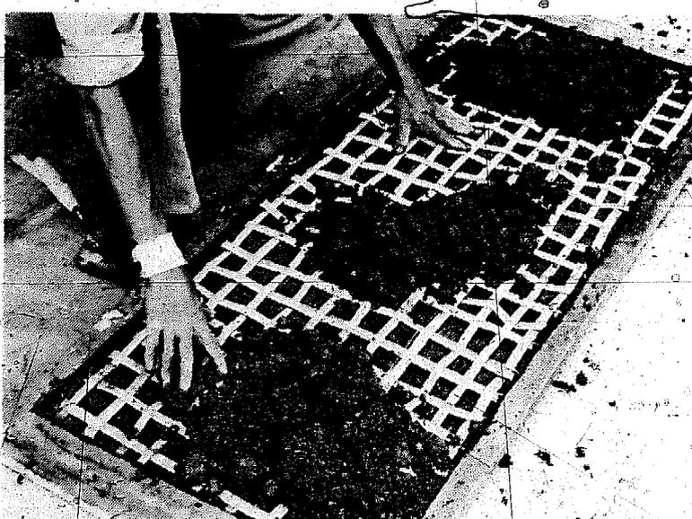
*Figura 4-33 Colocación de la capa superior de mortero.*
