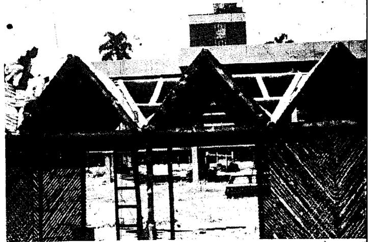
*Figura 3-17. Construcción del sobretecho.*
