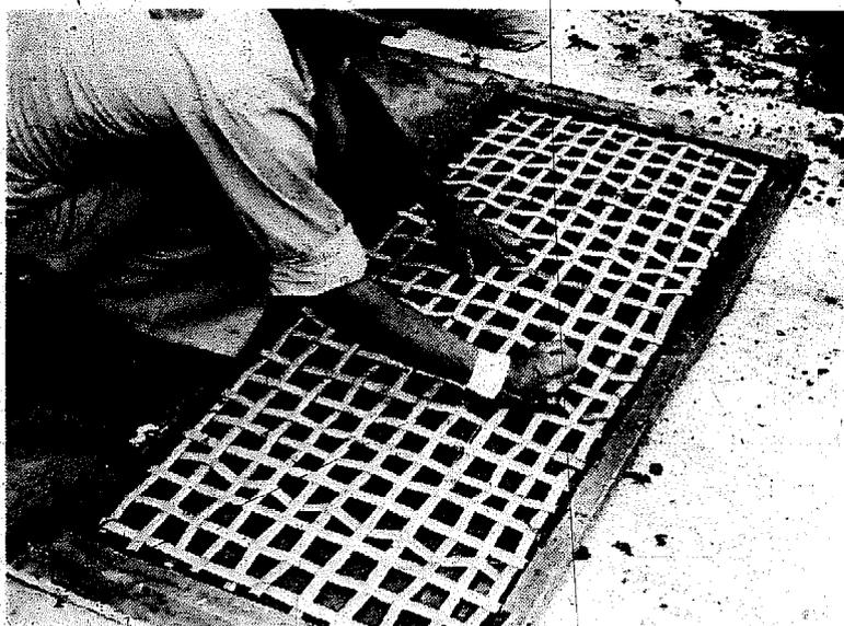
*Figura 4-32 La malla se comprime contra el mortero.*
