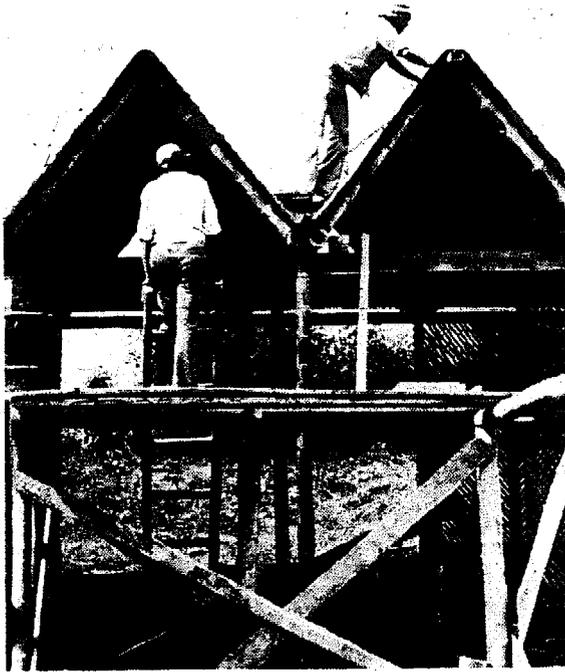
**Figura 3-27.** Debe construirse un andamio para colocar una lina con agua y el mortero preparado.
