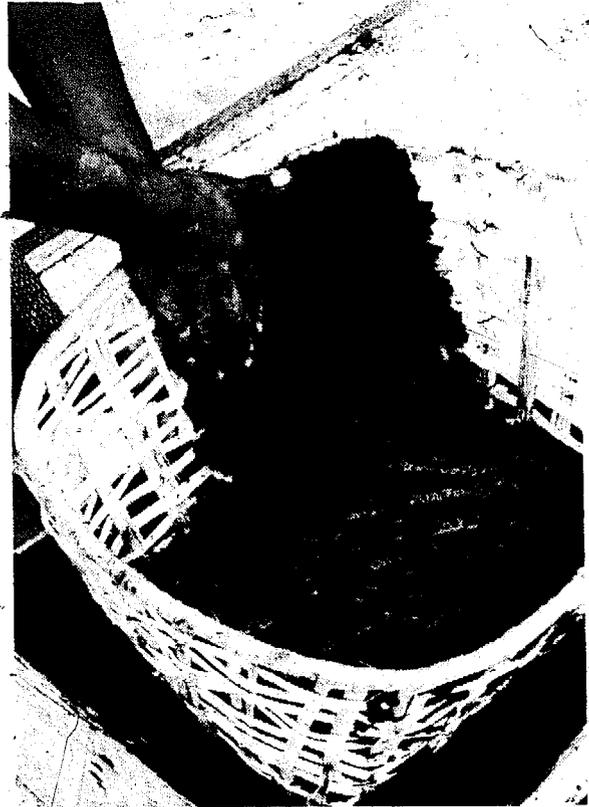
Figura 4-21. Luego se recubre con mortero el lado interior.
