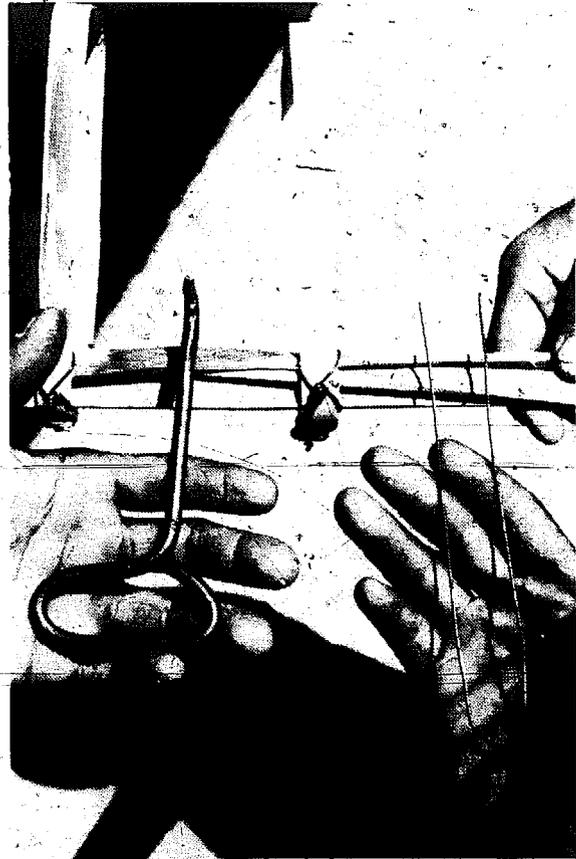
Figura 5-25. Gancho y alambre utilizados en el amarre del castillo.
