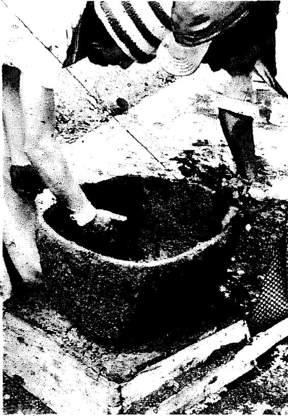
Figura 4-24. Aplicación de la segunda capa interna.
