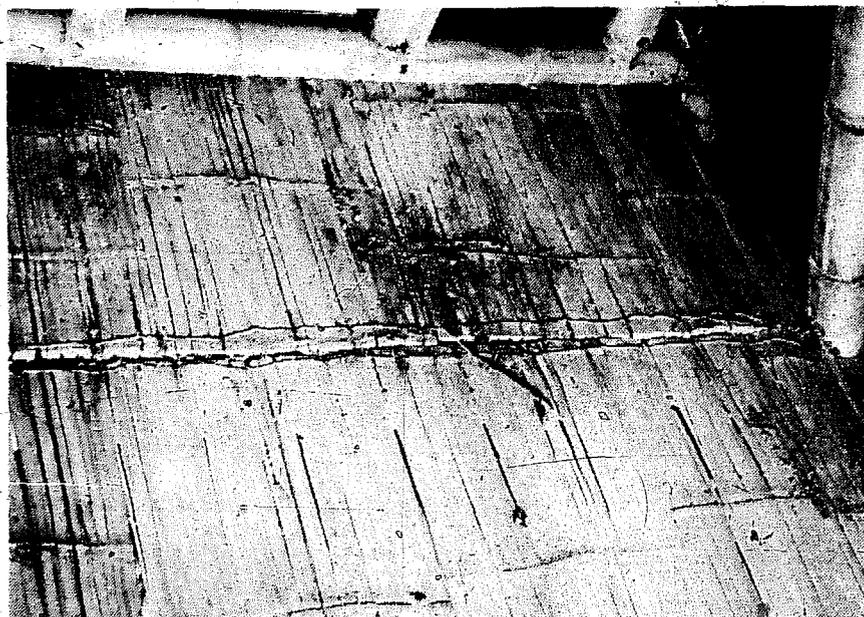
Figura 2-20. Piso de esterilla del entrepiso. Cuando se empleen esterillas cortas, su unión debe hacerse en lo posible en el área de la tolva y no en la zona de tráfico.
