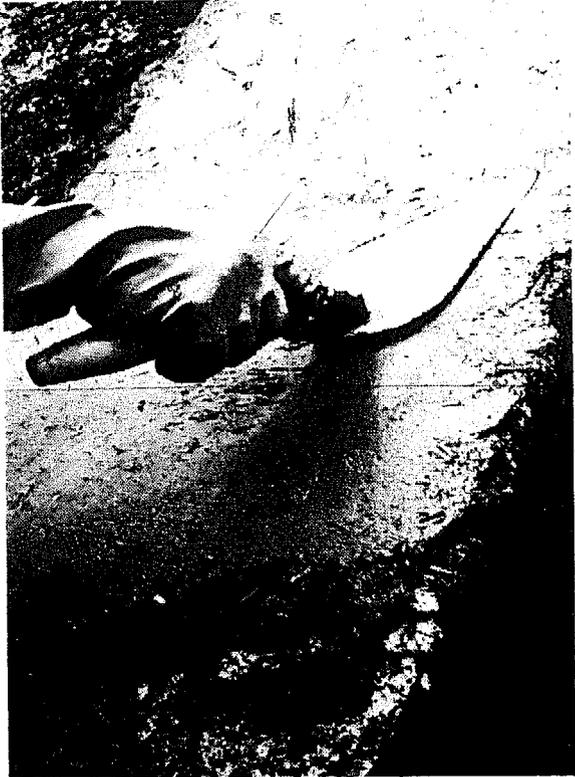
**Figura 3-31.** Finalmente la superficie se esmalta con ayuda de una yana metálica o a falta de ella con un palustre.
