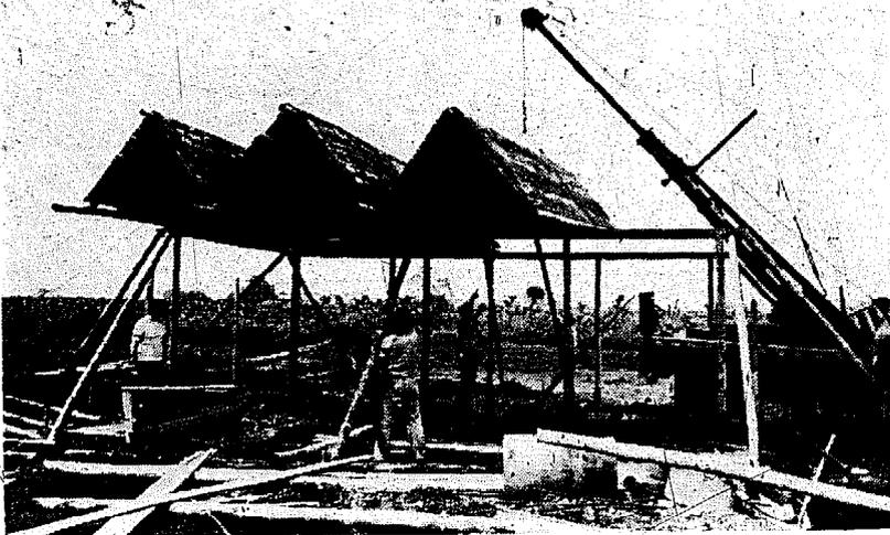
Figura 3-12. Colocación de la tercera armadura.
