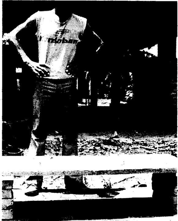
*Figura 4-38. Las plaquetas para mesas de cocina deben tener un espesor mínimo de 5 centímetros y apoyarse sobre soportes de ladrillo o madera separados 50 centímetros.*
