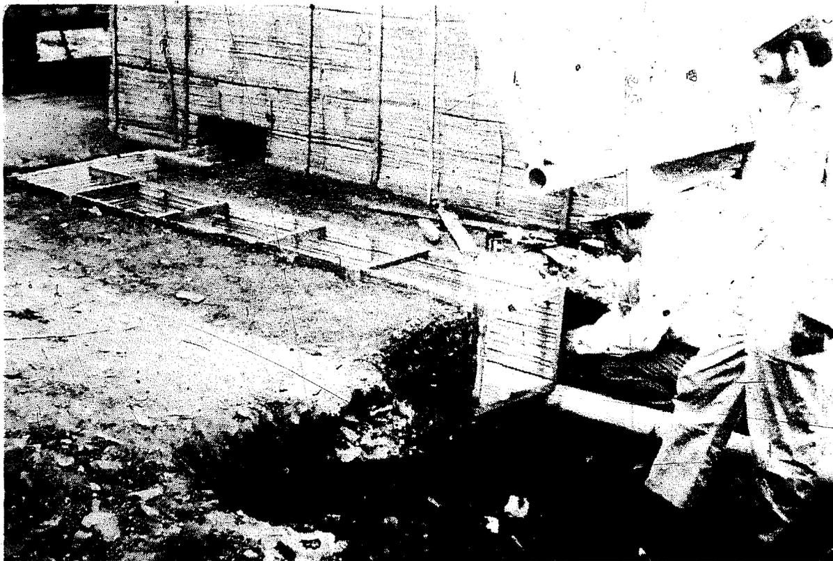
5. El canal puede construirse en dos formas: La primera consiste en utilizar el método de construcción de los tanques, que se indica en otra parte de esta publicación, o sea haciendo primero la canal tejida con cintas de guadua y recubriéndola luego con mortero de
