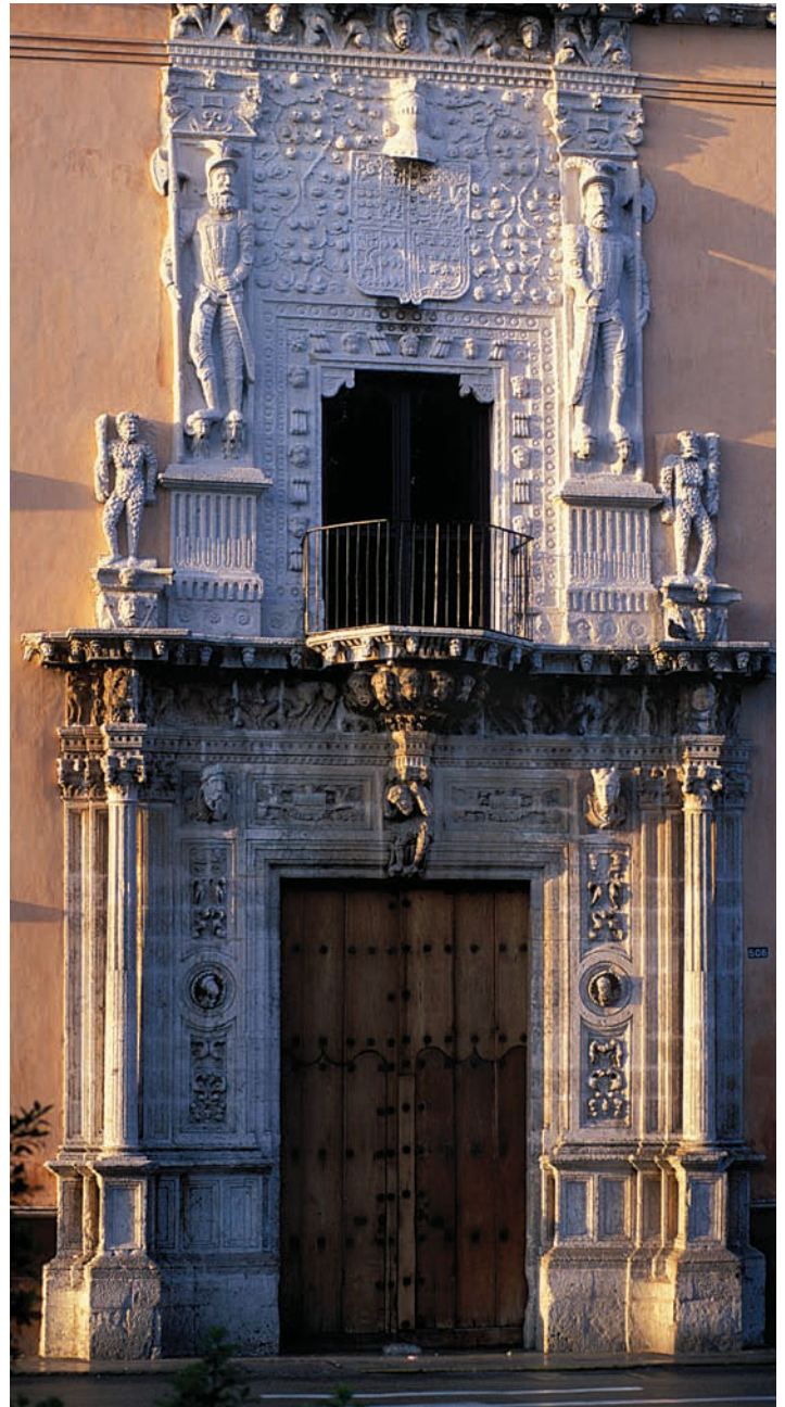
18-23 Portal, Casa de Montejo, Mérida, Mexico, 1549.
