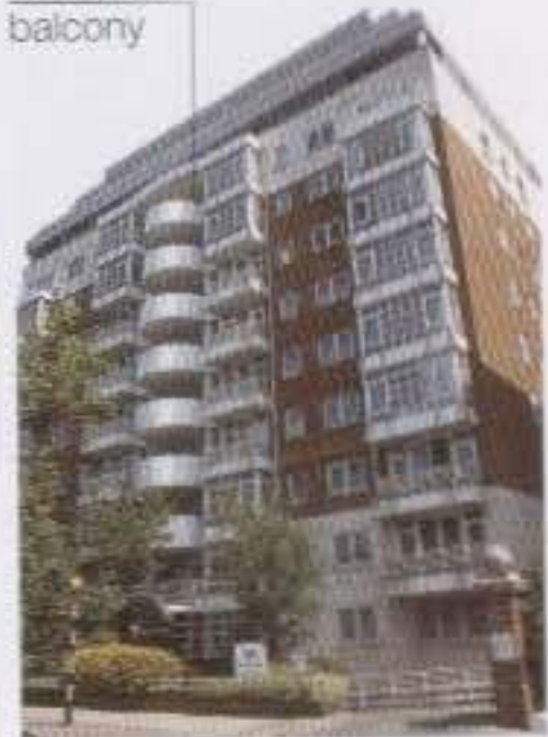
el edificio apartment block
