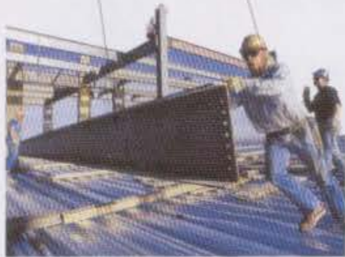
construir build (v)
