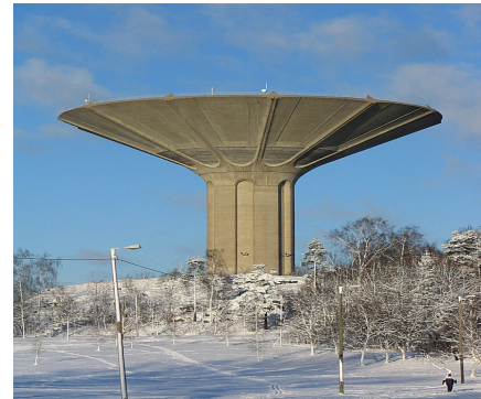
Figura 7.2. Tipuri de structuri: sisteme flexibile la torsiune (a), sisteme de tip pendul inversat (b), exemplu – un castel de apă din b.a. ( http://en.wikipedia.org/wiki/Water_tower ).
