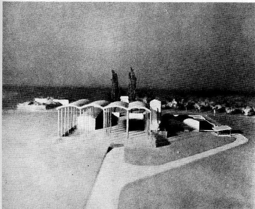
Idem, vue du côté de la grange (construction métallique avec remplissage des voûtes en béton léger recouvert de terre)
