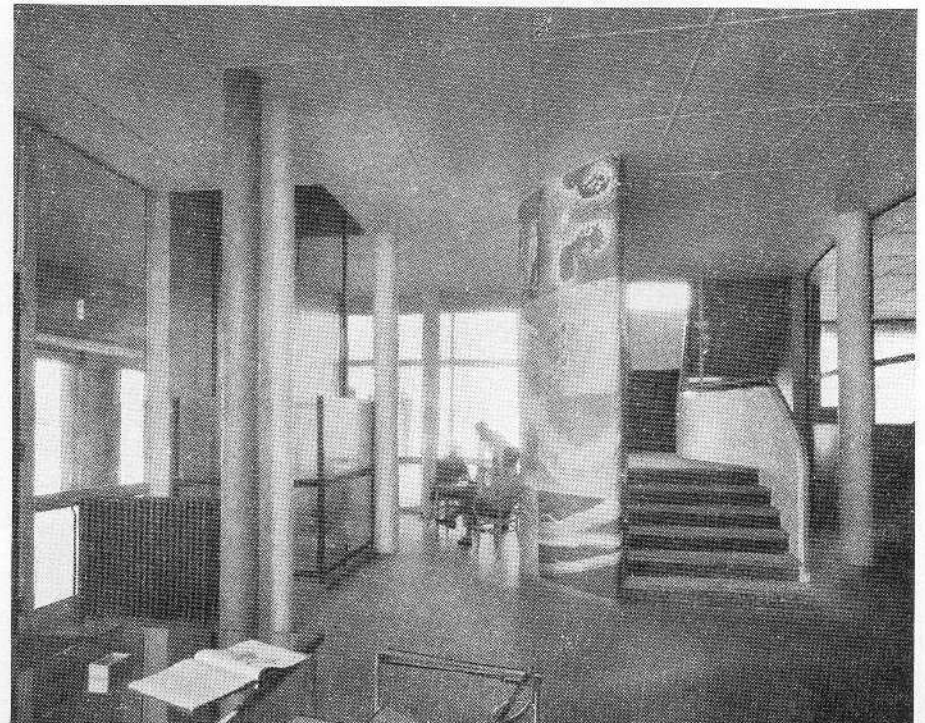
Le plan libre: les poteaux, les gaines, les parois courbes, l'escalier sont autant d'organes
