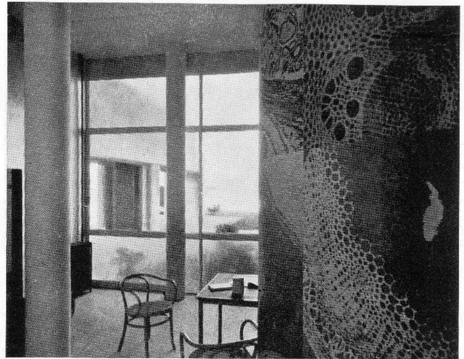
Une gaine de chauffage, tuyauterie, recouverte d'agrandissements photographiques
