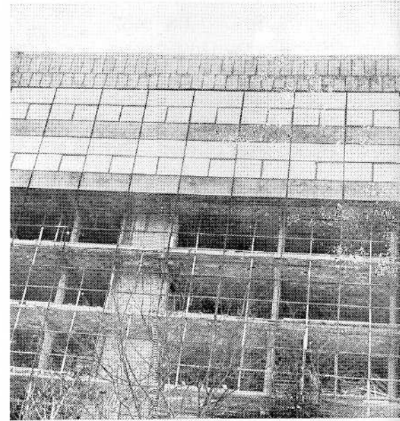
En cours de construction
