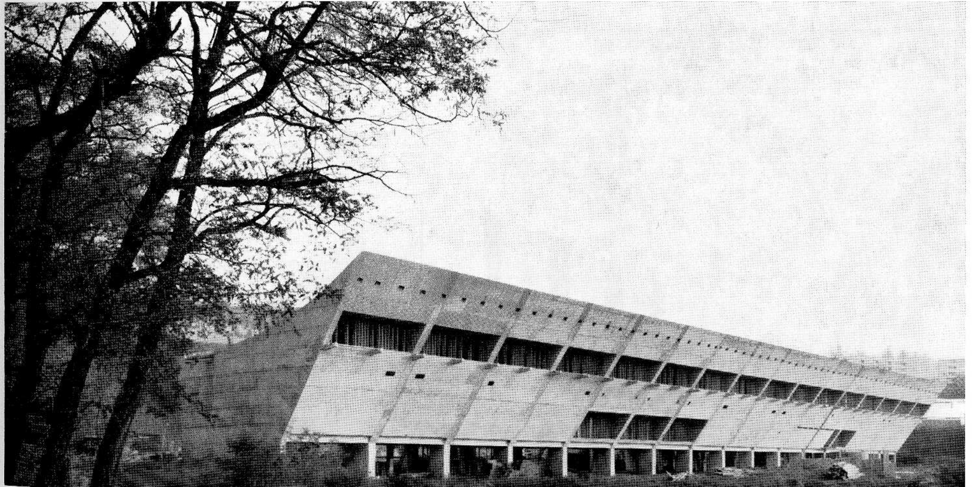
La Maison des Jeunes à Firminy. Façade ouest
