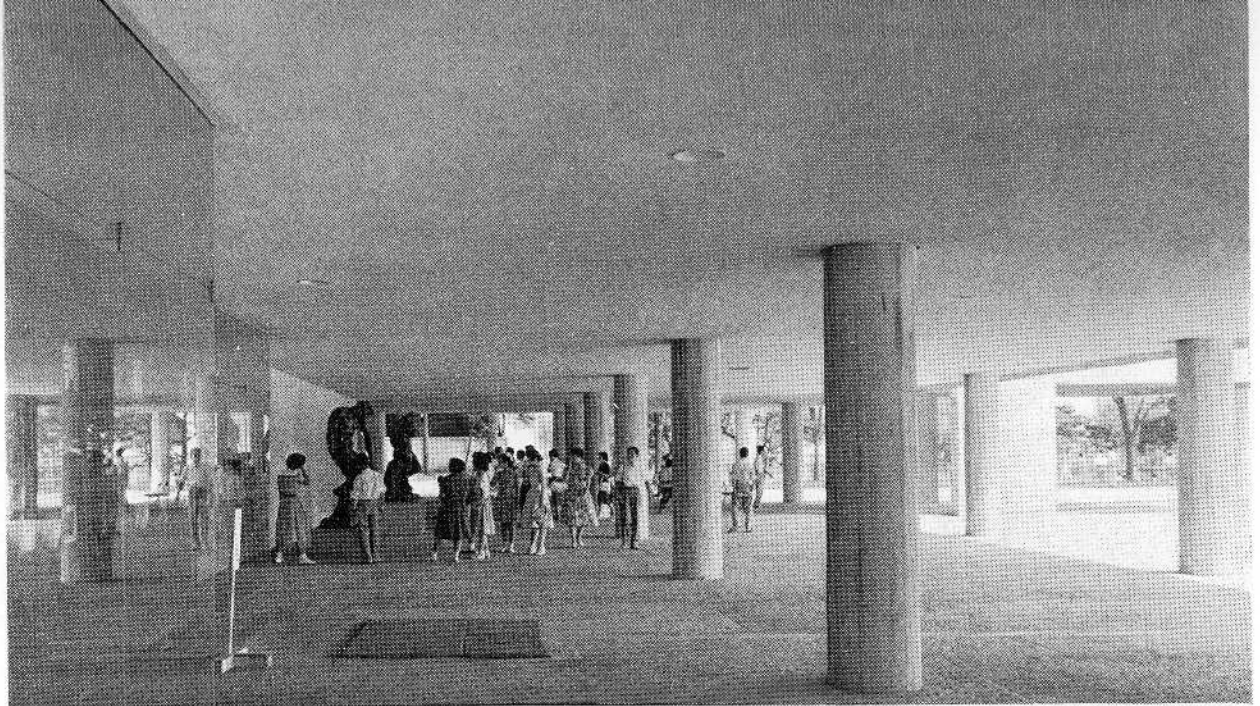
L'entrée sous les pilotis / Ground floor entrance / Erdgeschoss
