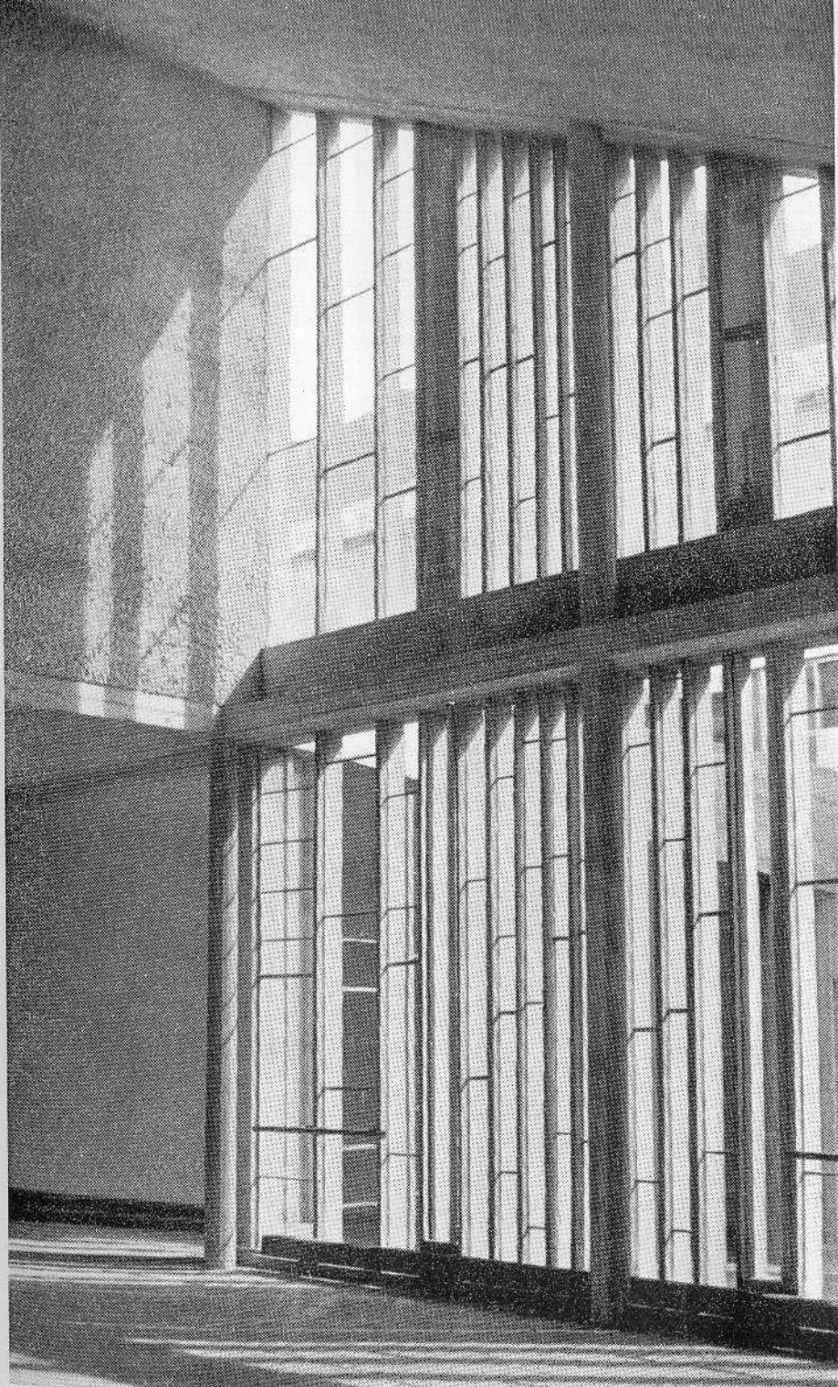
Les « ondulatoires » suppriment les serrureries ouvrantes / Die « ondulatorische » Verglasung
