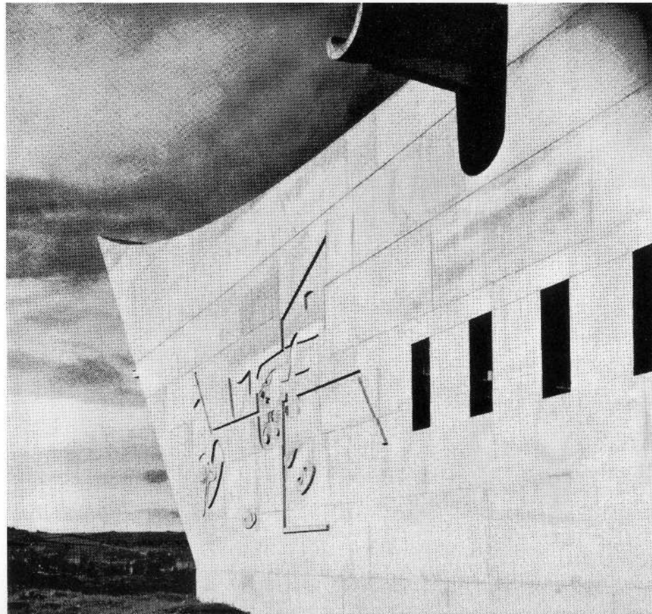
La façade sud avec la gargouille
