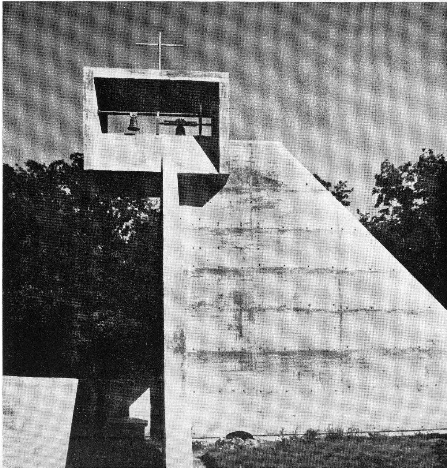
Le clocher est accessible de la toiture; cette toiture est constituée par une surface d'herbe protégeant le béton contre la dilatation (froid et chaud)
