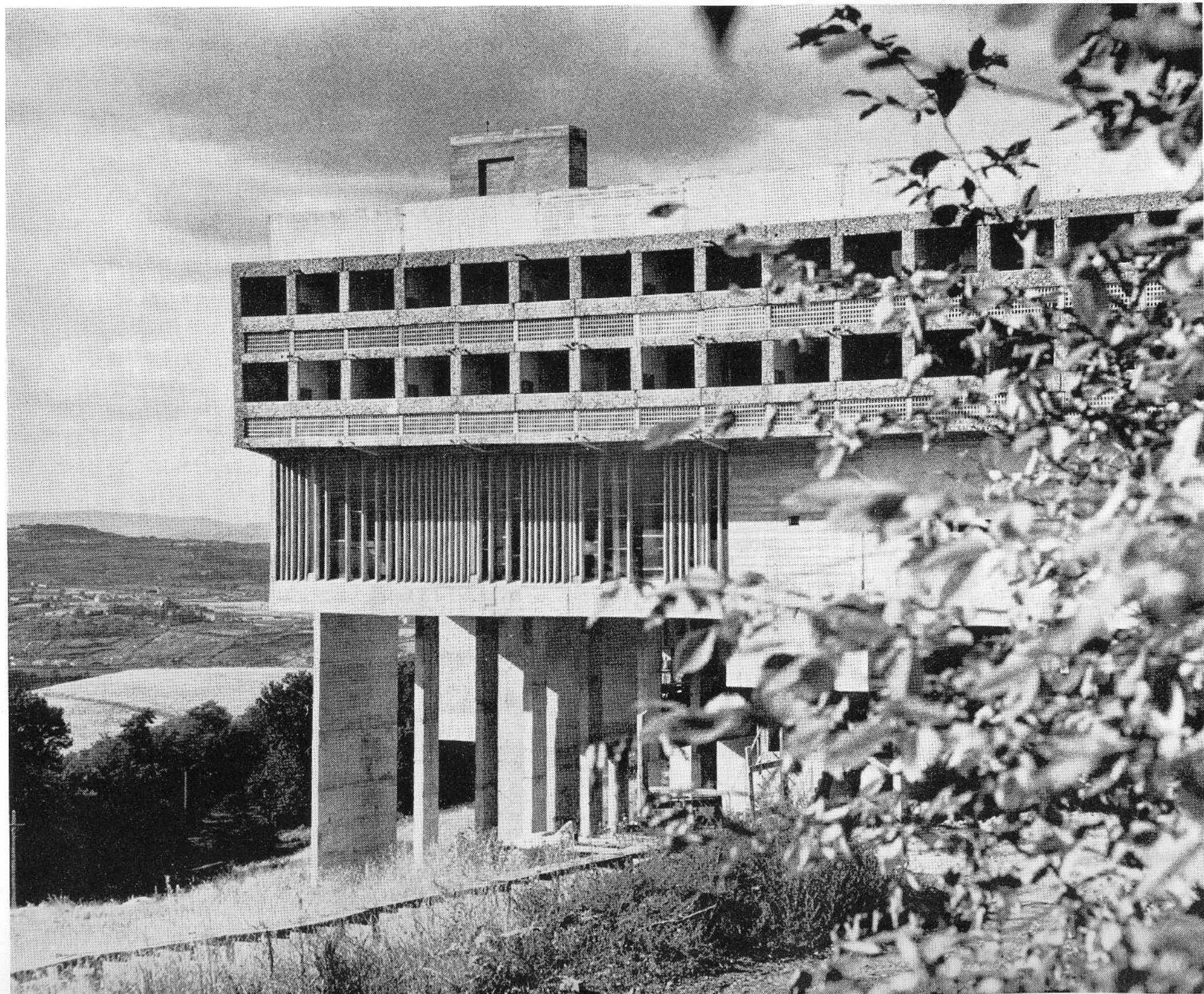
L'aile gauche de la façade sud / The left wing of the South elevation / Der linke Flügel der Südfassade
