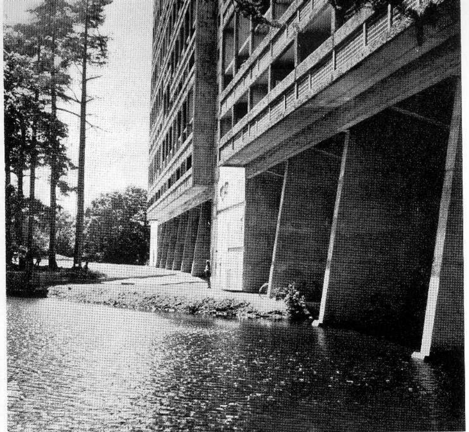
Unité d'Habitation à Nantes-Rezé, 1953. La façade est et l'étang
