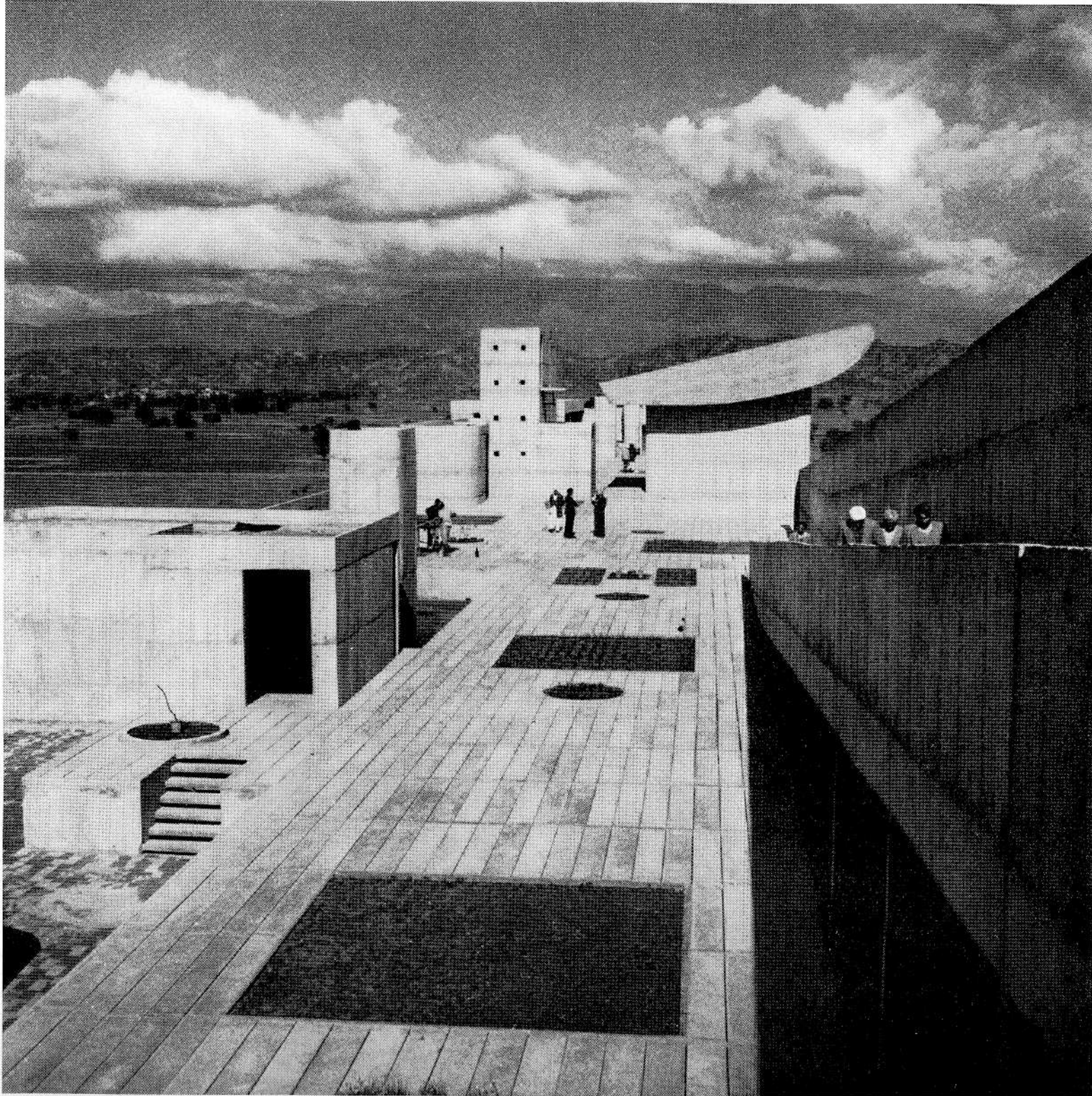
Le toit terrasse du Secrétariat / The roof-terrace of the Secretariat / Blick auf das Dach des Sekretariates
