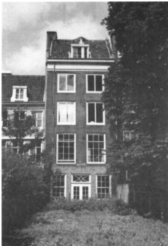
Вид на убежище со стороны 50-и квартирного дома
