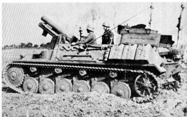
Plates 99-101. 15cm sIG33 auf Fgst Pz Kpfw II (Sf): Plate 101 shows the prototype vehicle.
